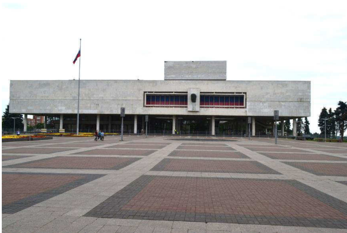
Фото 2. Общий вид южного фасада.
