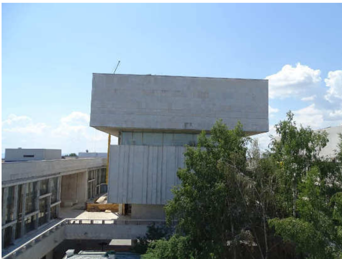
Фото 9. Общий вид башни Октябрьского зала, северный фасад.
