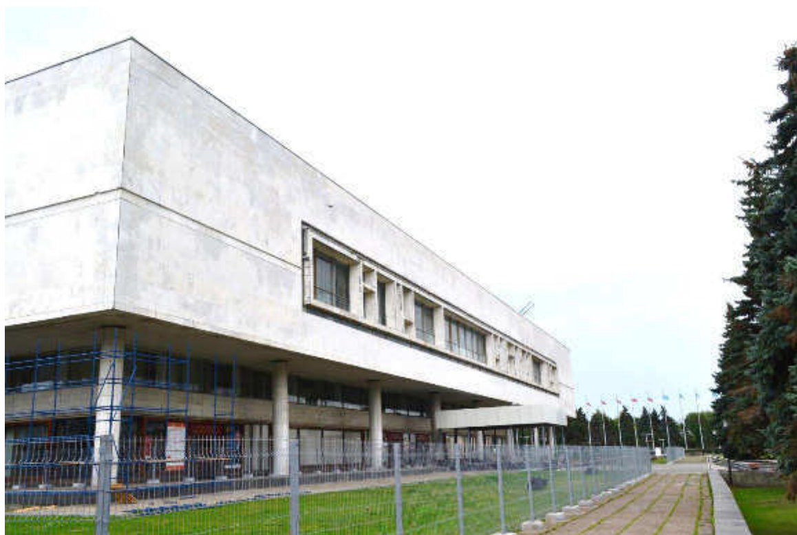
Фото 1. Общий вид западного фасада.
