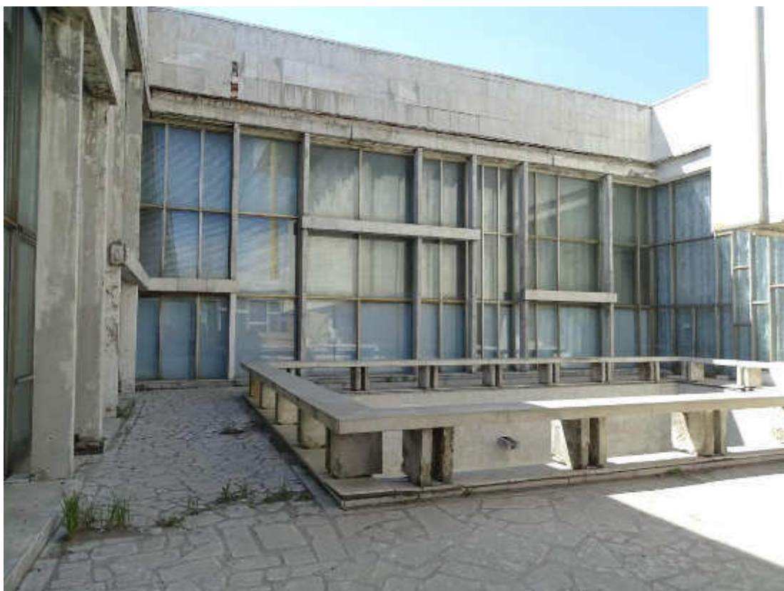
Фото 8. Общий вид балкона второго яруса (на отм. +9.270).
