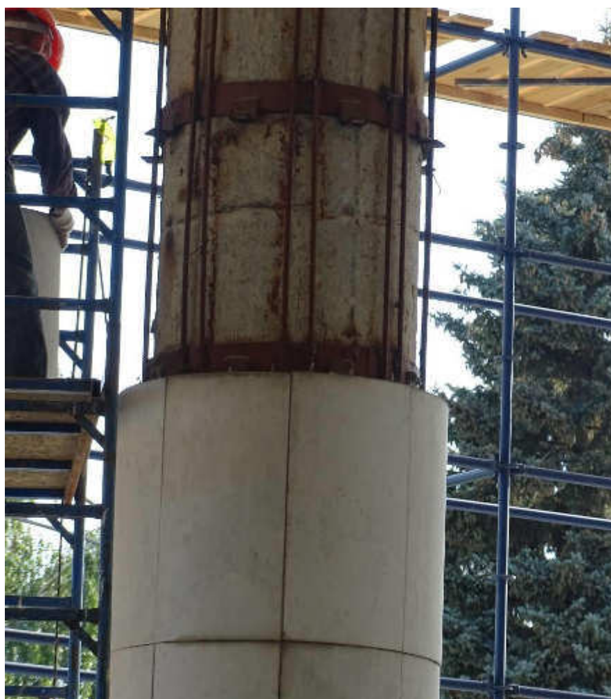
Фото 15. Вид колонны в процессе демонтажа.
