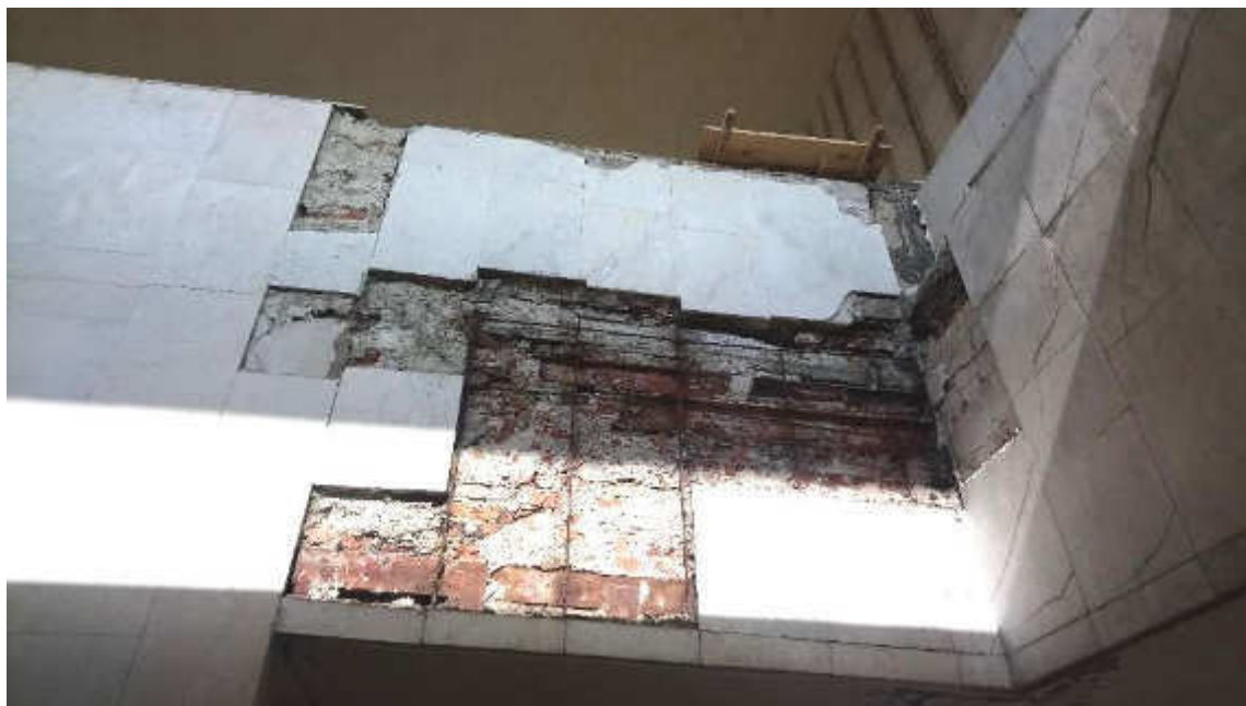
Фото 14. Фрагмент стены после демонтажа аварийного участка с элементами металлического каркаса под облицовкой.
