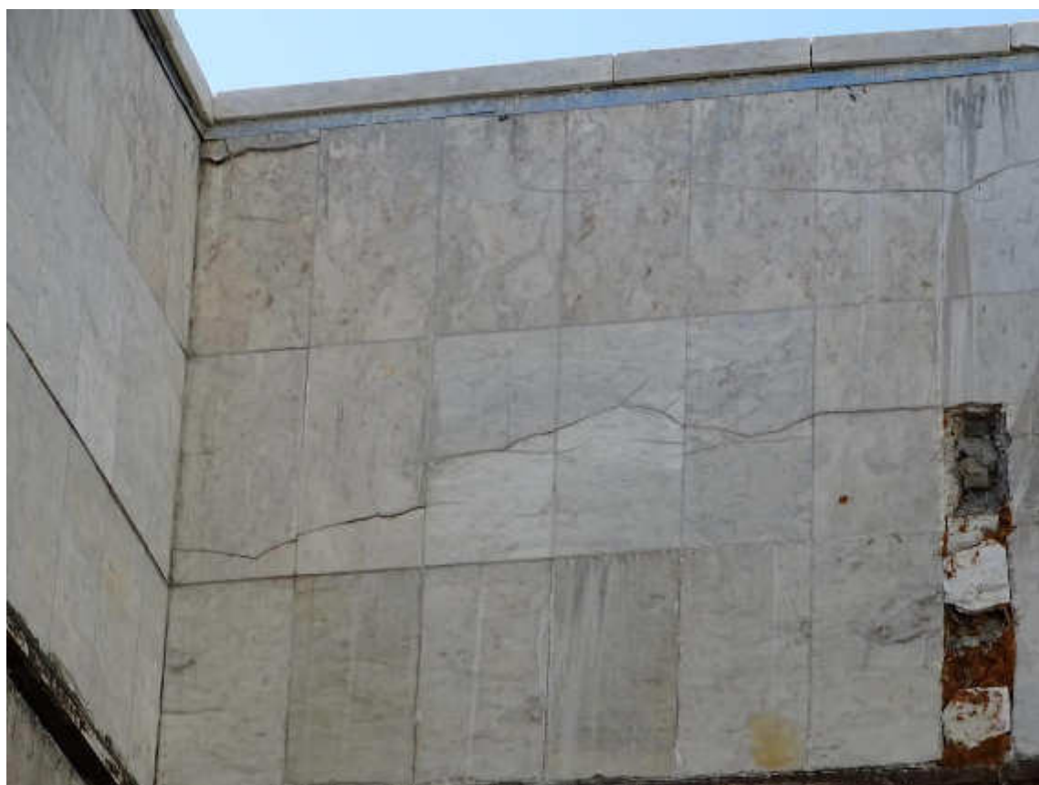
Фото 11. Фрагмент облицовки северного (дворового) фасада.
