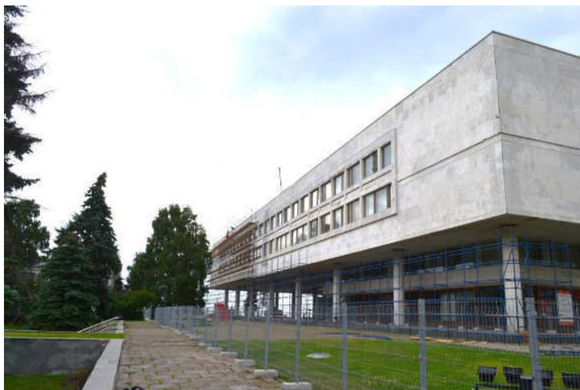
Фото 5. Общий вид северного фасада.
