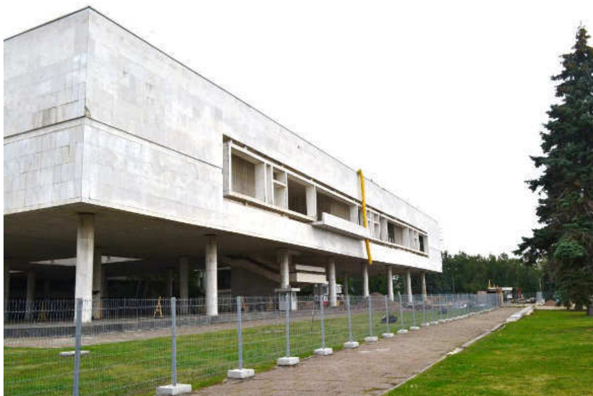
Фото 4. Общий вид восточного фасада.
