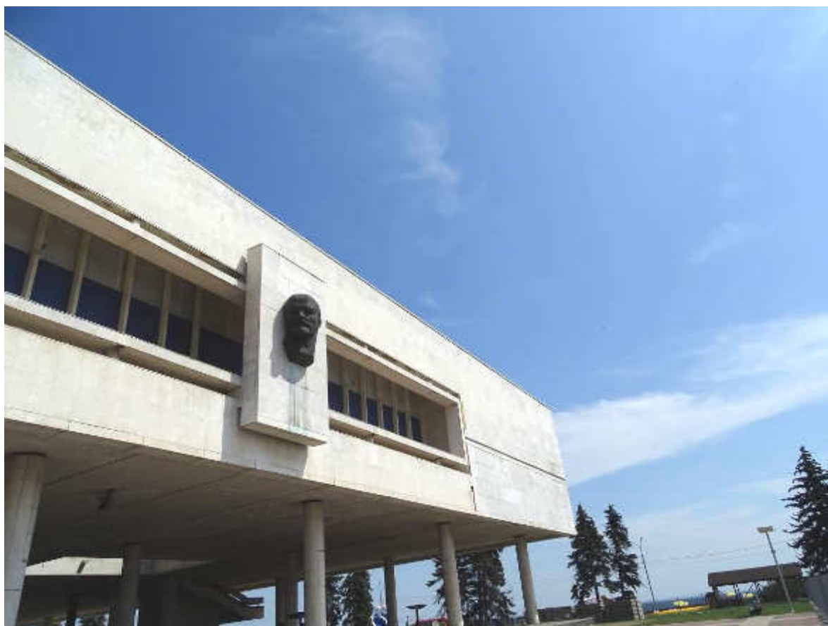
Фото 3. Фрагмент южного фасада.
