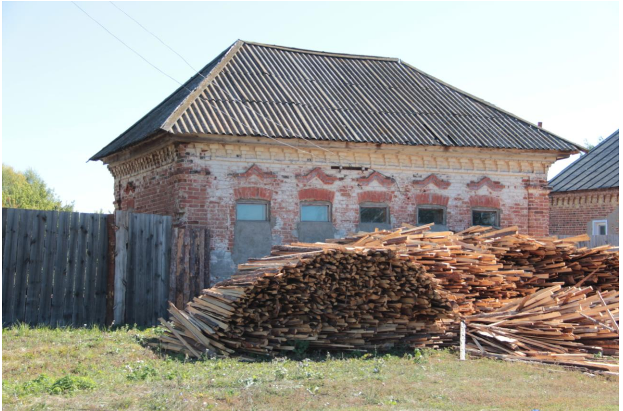
Общий вид на объект
