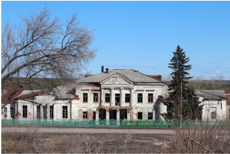
Общий вид на объект
