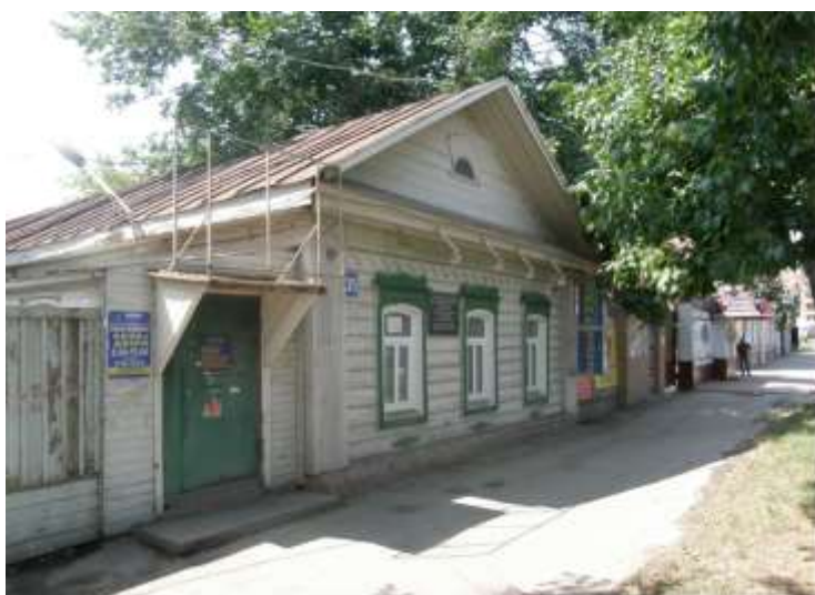
4. «Дом, в котором жил народник Чугунов Сергей Михайлович и бывал Ульянов Александр Ильич», 1865-1889 гг. Общий вид с юго-востока. Главный фасад. Фото Е.Н.Сергеенко, 06.06.2014
