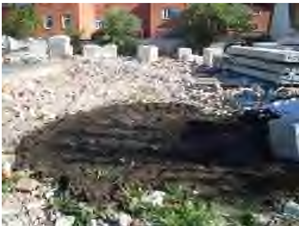
Рис. 14. Объект «Земельный участок общей площадью 2332 кв. м. с кадастровым номером 73:24.041604:1018 по адресу г. Ульяновск, ул. Радищева, 91а». Рекультивация рекогносцировочного шурфа № 1. Вид с С.
