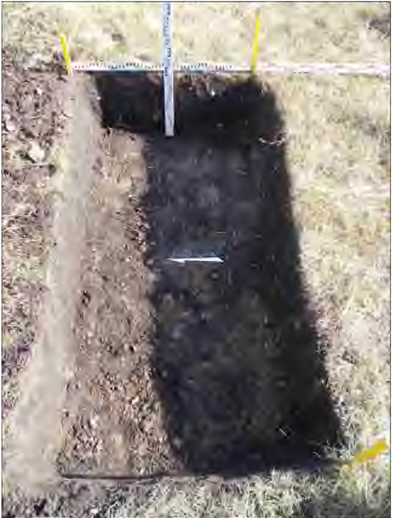
Рис.44. Земельный участок, отводимый под строительство объекта: «Газопровод межпоселковый...». Разведочный шурф №3. Вид с 3 (ближний план)
