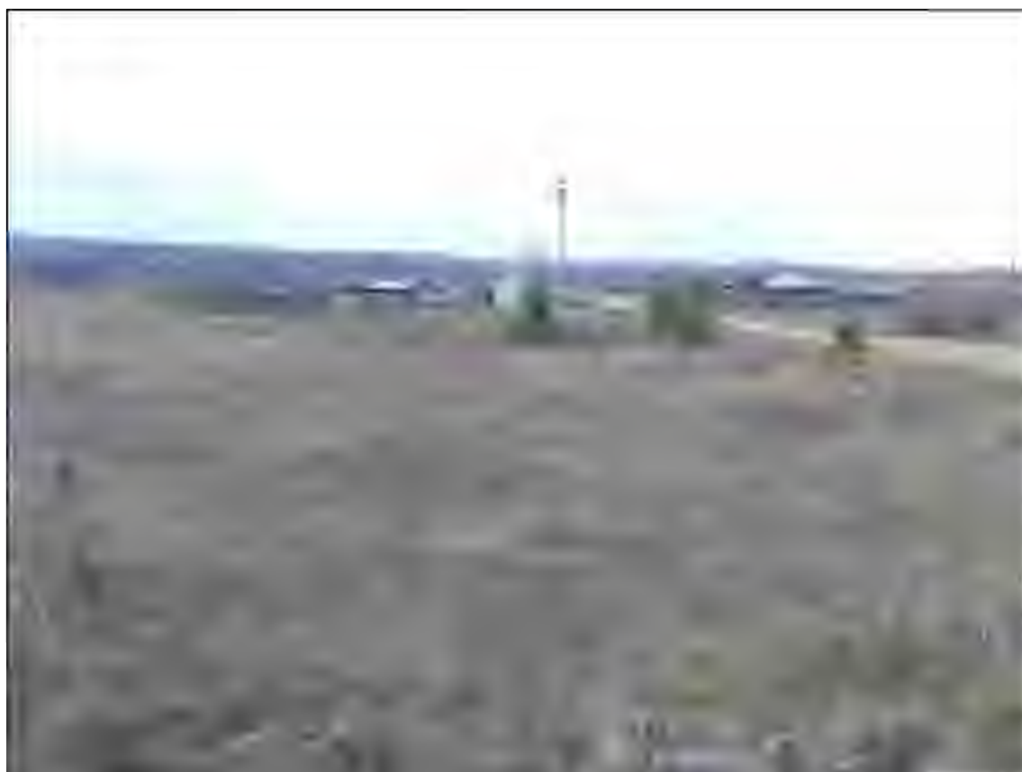
Рис 4 Земельный участок, отводимый под строительство объекта: «Газопровод межпоселковый...». Отрезок Болдасьево – Барановка. Начальный пункт обследования в с. Болдасьево. Вид с СВ
