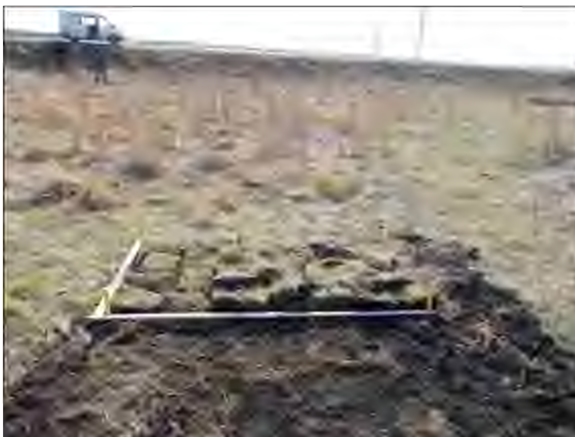
Рис.46. Земельный участок, отводимый под строительство объекта: «Газопровод межпоселковый...». Рекультивированная площадка шурфа №3. Вид с С
