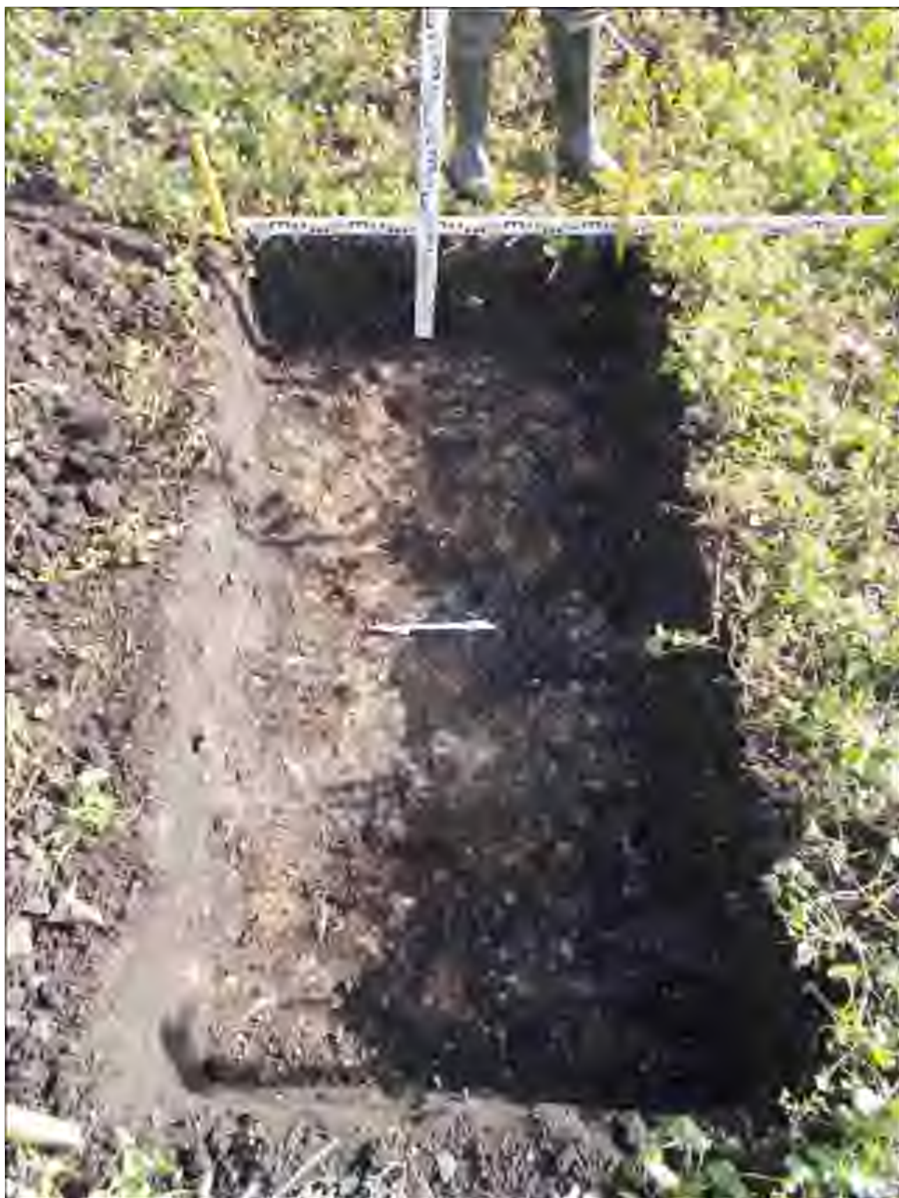
Рис.55. Земельный участок, отводимый под строительство объекта: «Газопровод межпоселковый ...» Реконсцировочный шурф №4. Вид с 3(ближний план)
