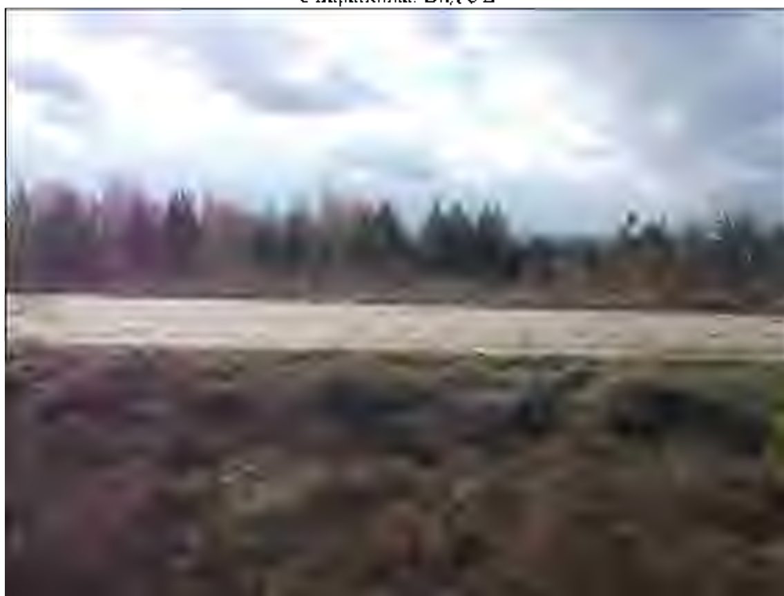
Рис.21. Земельный участок, отводимый под строительство объекта: «Газопровод межпоселковый...». Отрезок Болдасьево – Барановка. Переход трассой автодороги. Вид с С
