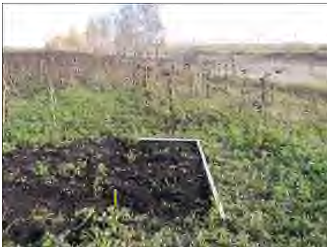
Рис.56. Земельный участок, отводимый под строительство объекта: «Газопровод межпоселковый...». Рекультивированная площадка шурфа №4. Вид с З
