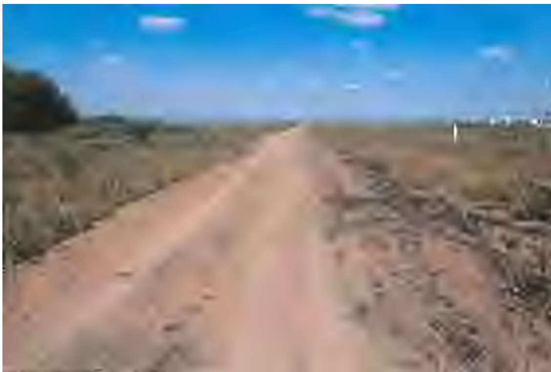
Рис. 15. Объект «Эксплуатационная скважина №58 Куликовского месторождения». Проектируемая подъездная дорога. Вид с ЮЗ.
