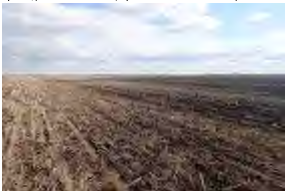
Рис. 8. Объект «Обустройство скважины №59 Куликовского месторождения». Проектируемый выкидной трубопровод от скважины № 59. Вид с ЮЮЗ.
