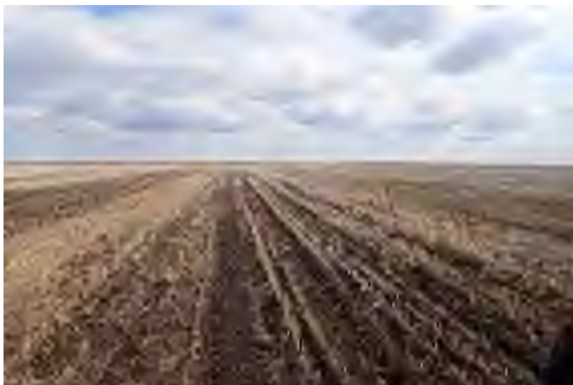
Рис. 3. Объект «Обустройство скважины №59 Куликовского месторождения». Проектируемая площадка под обустройство скважины № 59 с коммуникациями. Вид с Ю.
