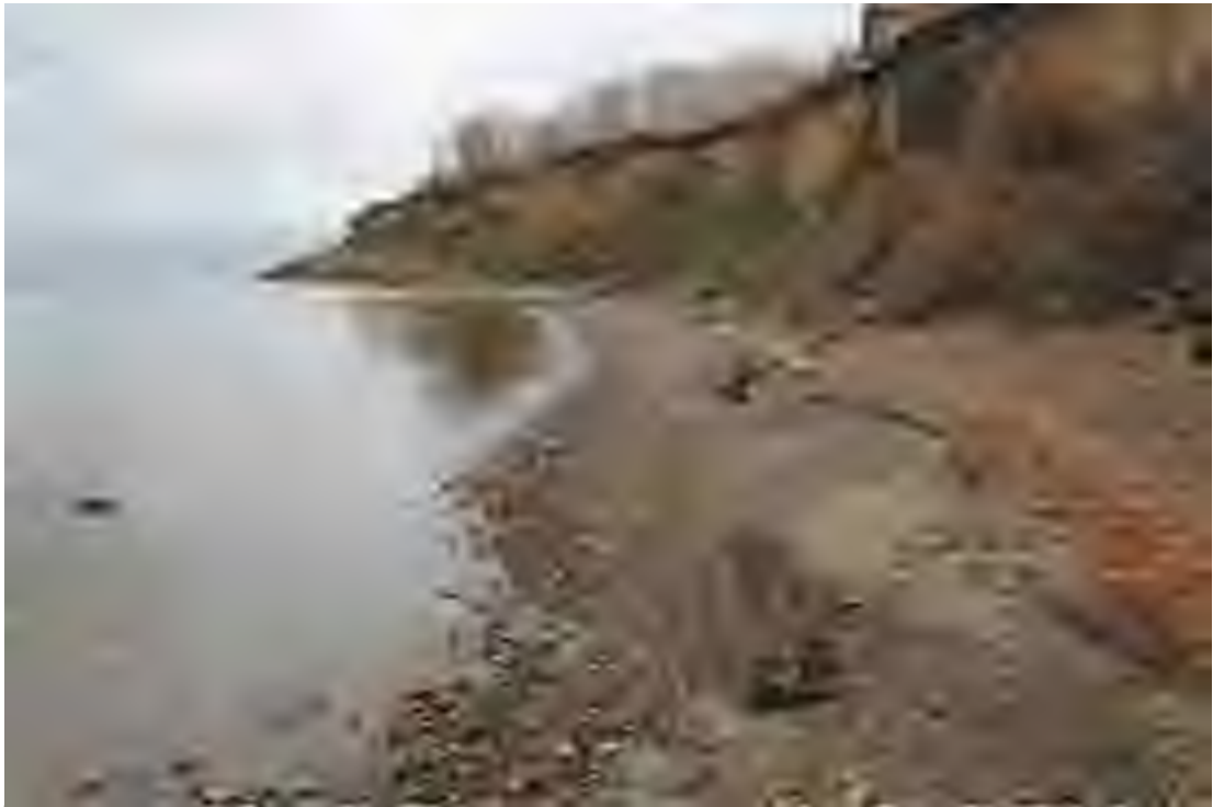
Рис. 5. Объект: «Берегоукрепительные сооружения на Куйбышевском водохранилище в районе с. Панская Слобода муниципального образования «город Новоульяновск» Ульяновской области». Вид с северной оконечности на Ю.
