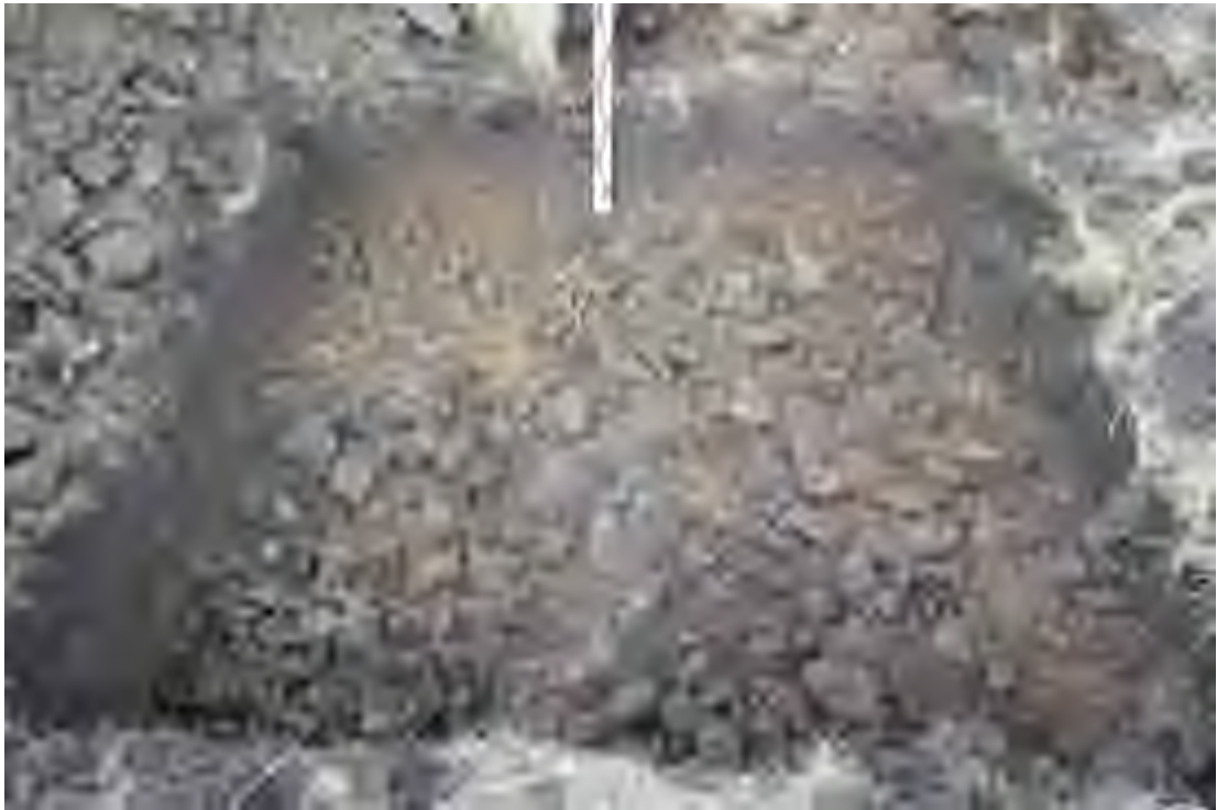
Рис. 25. Объект: «Водоводы Володарского нефтяного месторождения» в Радищевском районе Ульяновской области. Вид с Ю на контрольную прокопку дна шурфа 5.
