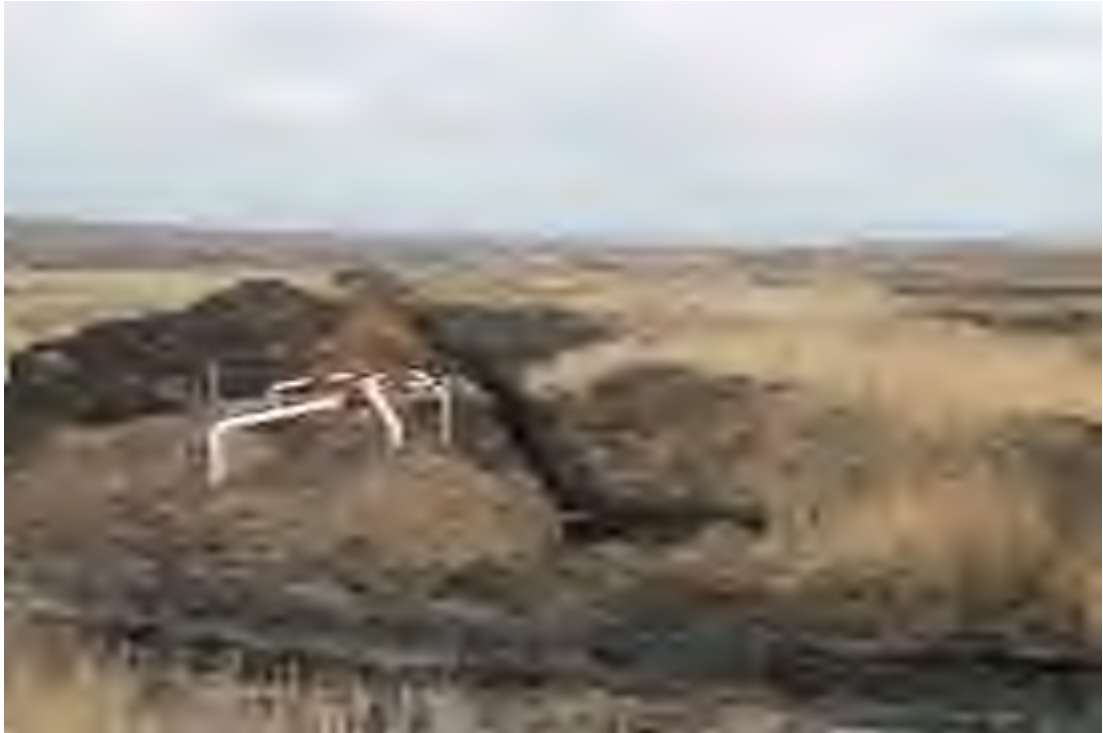
Рис. 3. Объект: «Водоводы Володарского нефтяного месторождения» в Радищевском районе Ульяновской области. Общий вид с ЮЗ.
