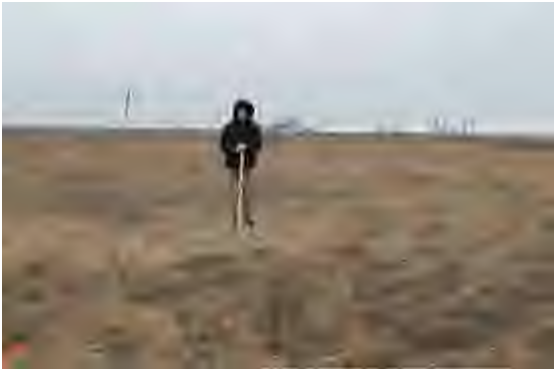
Рис. 27. Объект: «Водоводы Володарского нефтяного месторождения» в Радищевском районе Ульяновской области. Вид с С на разбивку шурфа 6.
