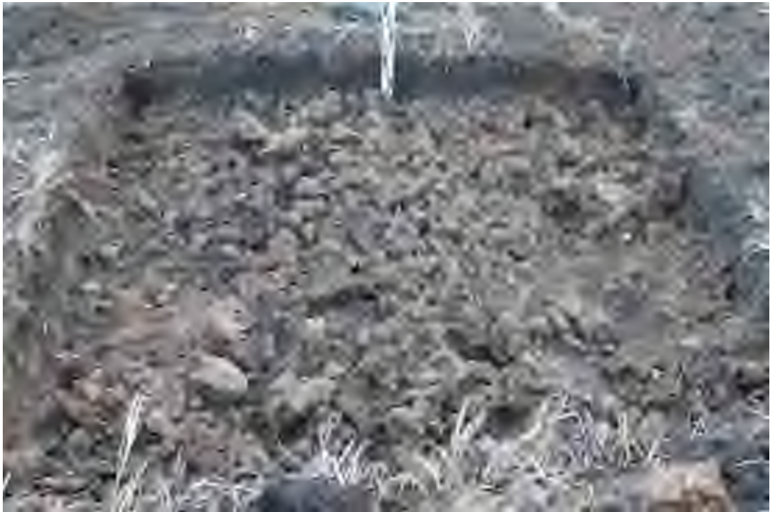
Рис. 17. Объекты: «Высоконапорный водовод от УПН-500 до скв. №140; Обустройство скв. №130; Производственная база НГДУ №2 «Север»; Обустройство. Куст № 1, Расширение. Филипповского п/м» на территории Мелекесского района Ульяновской области. Вид с Ю на контрольную прокопку дна шурфа 3.
