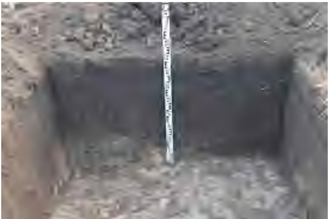
Рис. 32. Объекты: «Высоконапорный водовод от УПН-500 до скв. №140; Обустройство скв. №130; Производственная база НГДУ №2 «Север»; Обустройство. Куст № 1, Расширение. Филипповского п/м» на территории Мелекесского района Ульяновской области. Вид на северную стенку шурфа 7.
