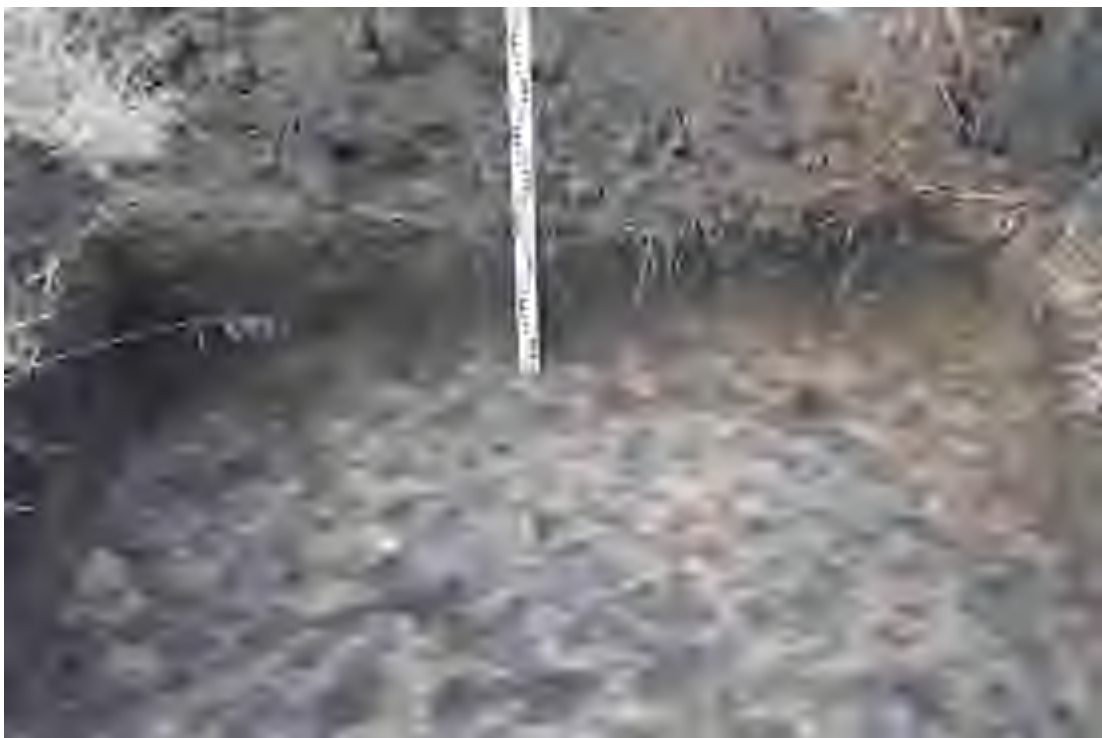
Рис. 28. Объекты: «Высоконапорный водовод от УПН-500 до скв. №140; Обустройство скв. №130; Производственная база НГДУ №2 «Север»; Обустройство. Куст № 1. Расширение. Филипповского п/м» на территории Мелекесского района Ульяновской области. Вид на северную стенку шурфа 6.
