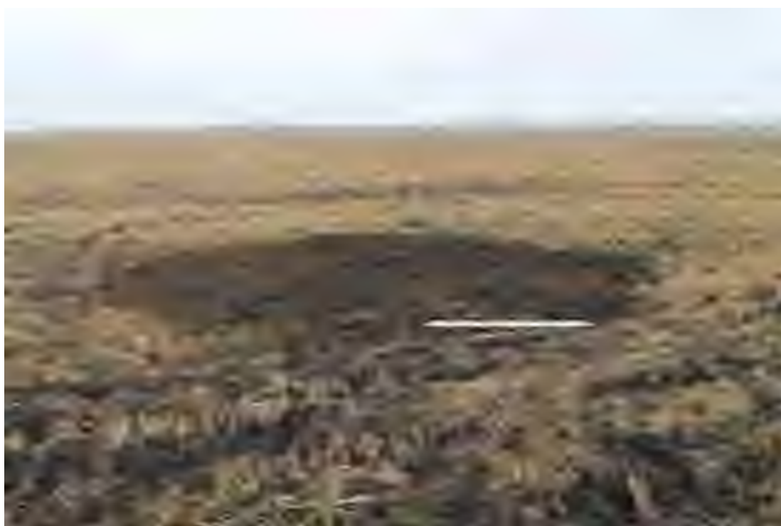
Рис. 8. Объект: «Высоконапорный водовод от задвижки скв. № 51 до задвижки скв. № 55 Южно-Филиповского нефтяного месторождения» в Мелекесском районе Ульяновской области. Вид с С на консервацию шурфа.
