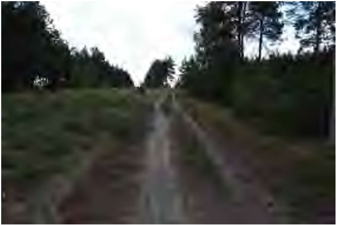
Рис. 3. Объект: «МН Куйбышев-Унеча-2, р Балашейка, 218 км, основная, DN1200. Реконструкция» в Сызранском районе Самарской области и Новоспасском районе Ульяновской области. Вид с З.
