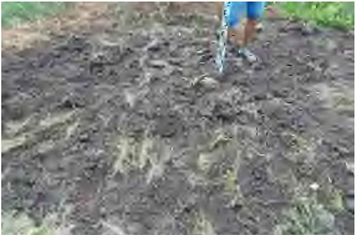
Рис. 16. Объект «МН Куйбышев-Унеча-2, р.Балашейка, 218 км, основная, DN1200. Реконструкция» в Сызранском районе Самарской области и Новоспасском районе Ульяновской области. Разведочный шурф I. Рекультивация. Вид с 3.
