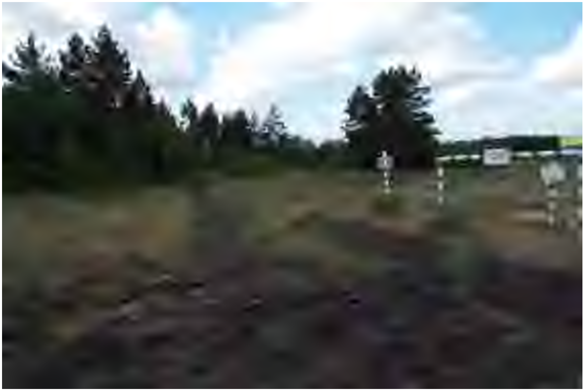
Рис. 5. Объект: «МН Куйбышев-Улеца-2, р.Балашейка, 218 км, основная. DN1200. Реконструкция» в Сызранском районе Самарской области и Повоспасском районе Ульяновской области. Вид с СВ.
