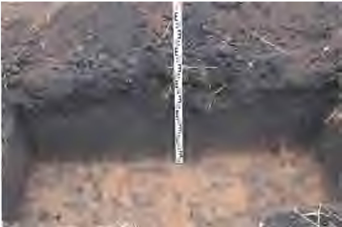
Рис. 12. Объект: «Нефтепроводы от задвижек скважин №№ 5, 10, 13 до АГЗУ куста скважин № 5 Новобесовского нефтяного месторождения» на территории Новомалыклинского района Ульяновской области. Вид на северную стенку шурфа 2.
