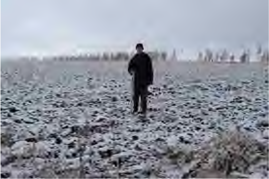
Рис. 7. Объект: «Нефтепроводы от задвижек скважин №№ 5, 10, 13 до АГЗУ куста скважин № 5 Новобессовского нефтяного месторождения» на территории Новомалыклинского района Ульяновской области. Вид с В на разбивку шурфа 1.
