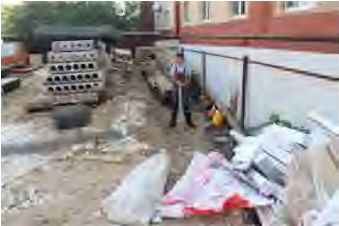
Рис. 13. Земельный участок по адресу: г. Ульяновск, ул. Красноармейская д. 132. Вид с 3 на разбивку шурфа.
