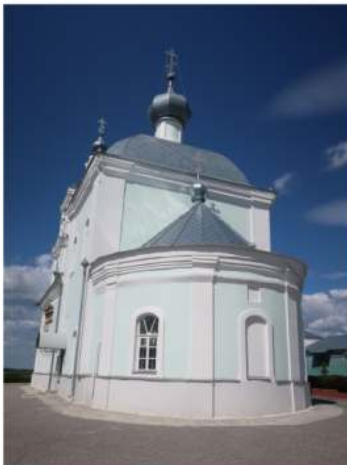
Вид на восточный фасад ОКН со стороны прилегающей территории. Фото 20.05.2022 г.
