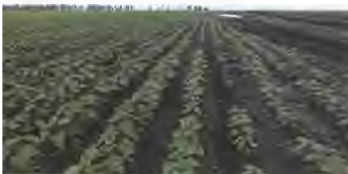
Рис. 52. Объект «Обустройство скважин №№ 50, 55 Кустовского месторождения». Проектируемые трубопровод и ВЛ. Вид с юг-юго-востока.
