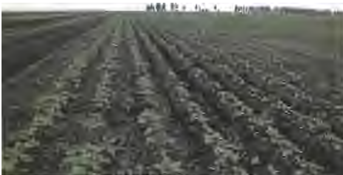
Рис. 55. Объект «Обустройство скважин №№ 50, 55 Кустовского месторождения». Проектируемые трубопровод и ВЛ. Вид с север-северо-запада.
