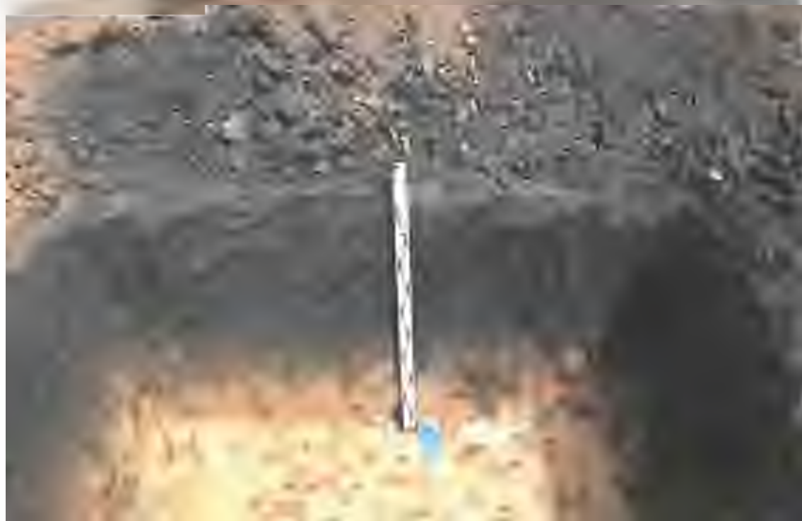
Рис. 62. Объект «Обустройство скважин №№ 50, 55 Кустовского месторождения». Северная стенка рекогносцировочного шурфа I. Вид с юга.
