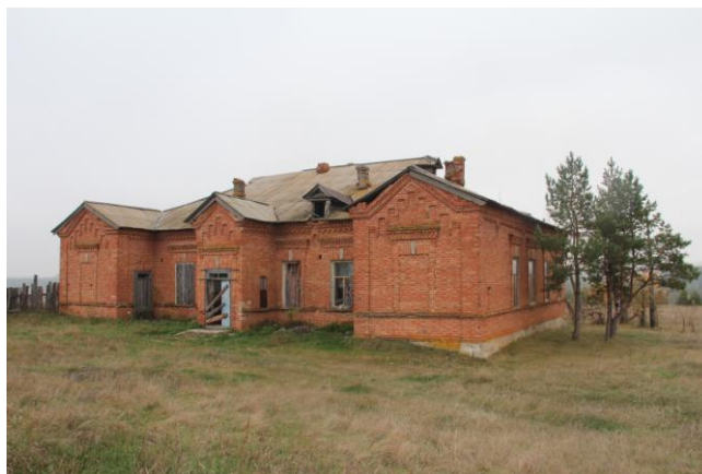
Юго- восточный фасад
