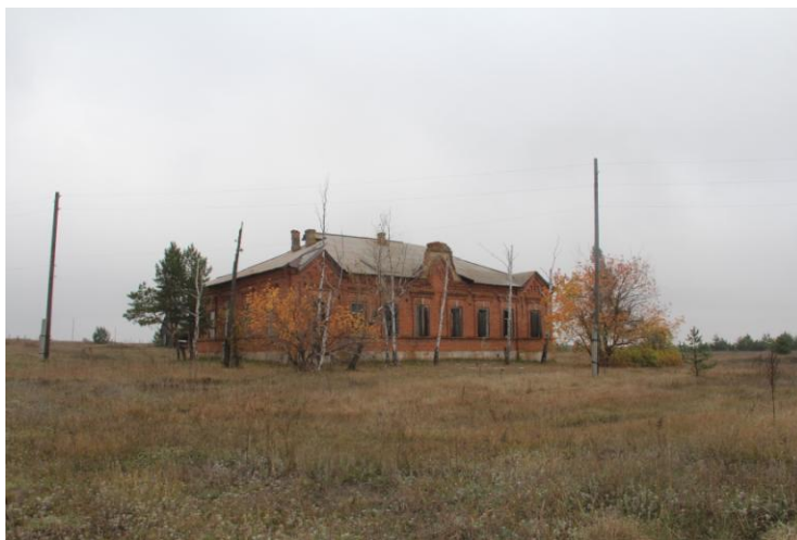
Общий вид на объект
