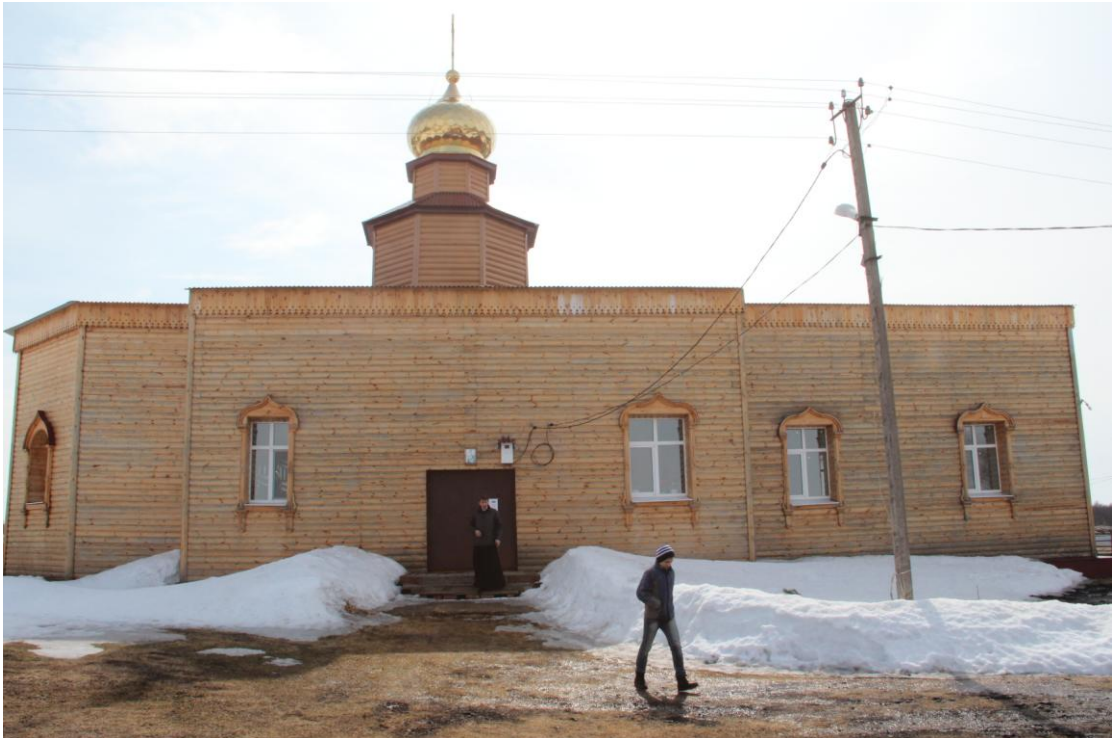
Общий вид объект
