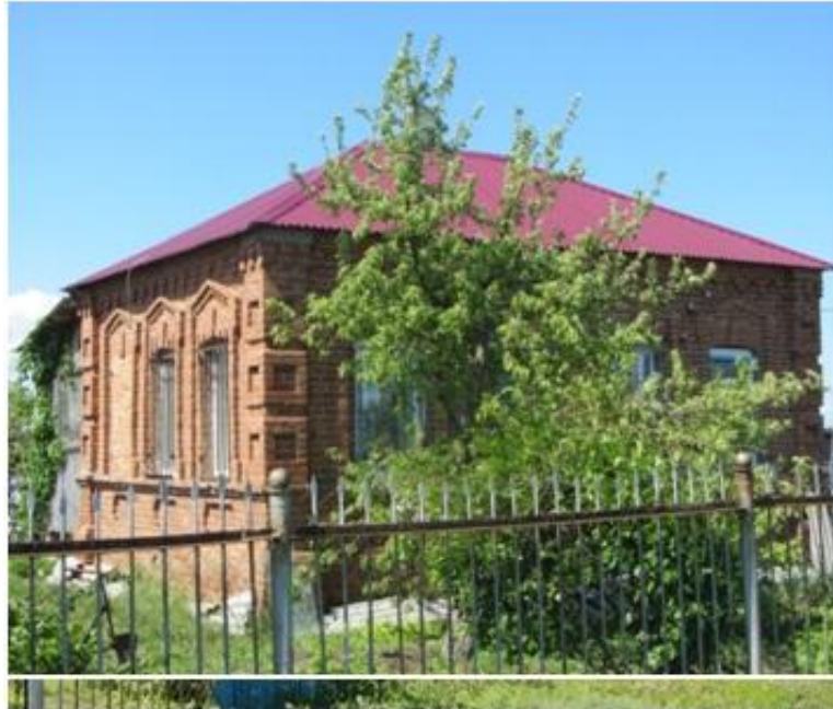
Общий вид на объект
