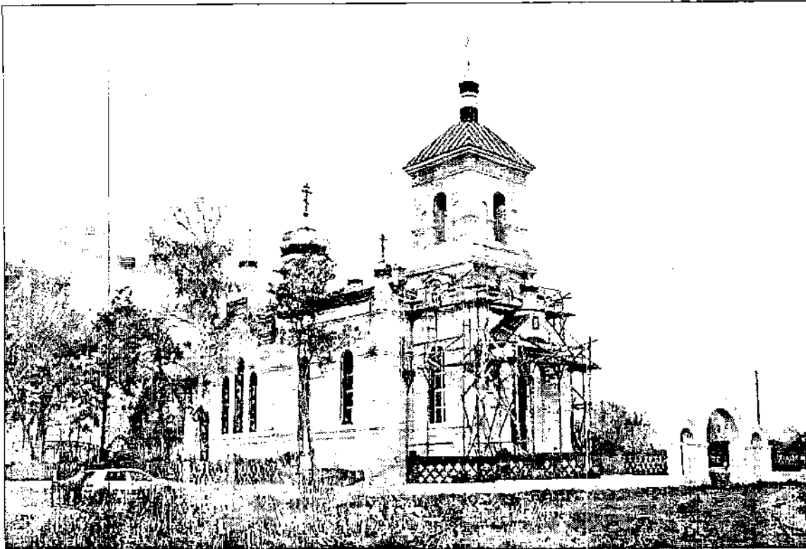
Ульяновская область, Старомайнский район, с. Ивановка. Вид с северо-запада. Церковь Боголюбской иконы Божией Матери в ходе реставрационных работ.
