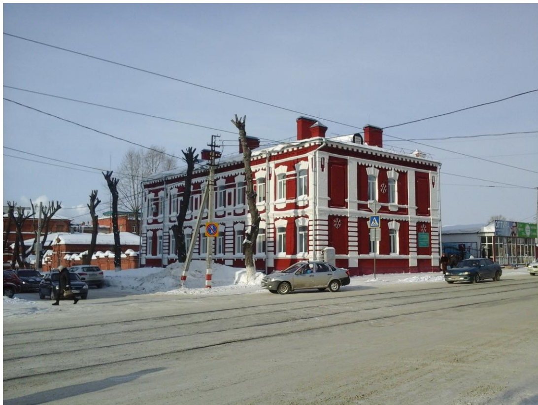
Общий вид на объект
