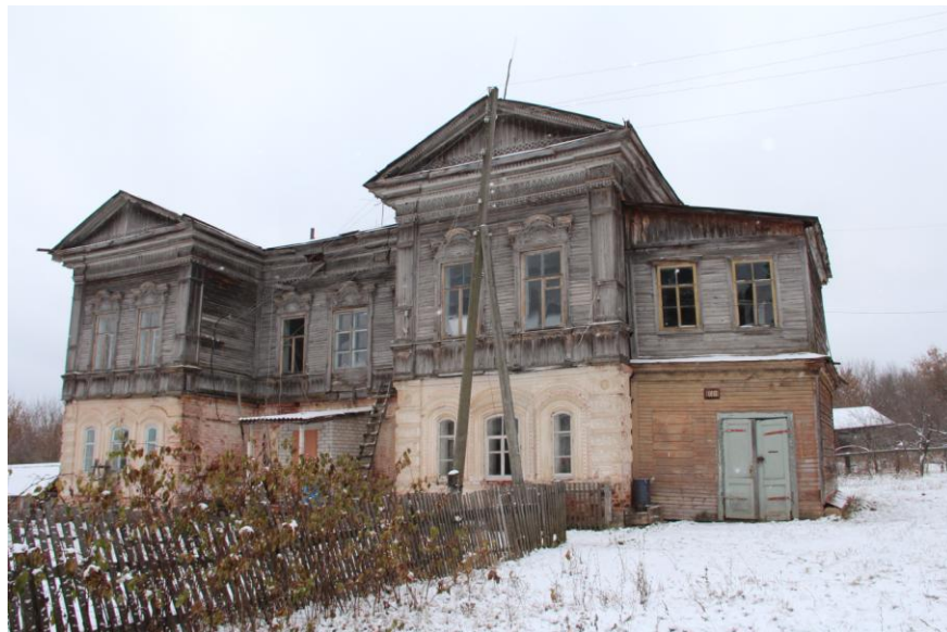
Общий вид на объект
