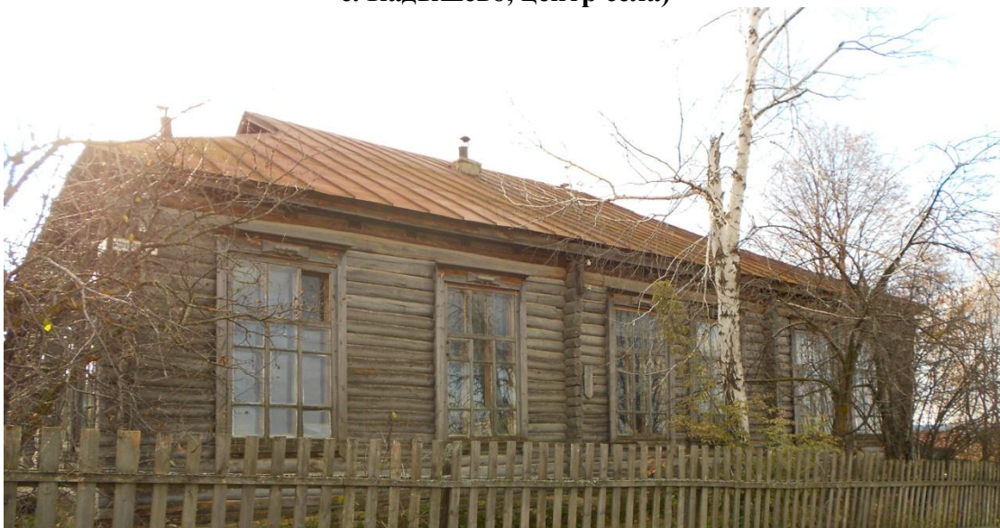
Общий вид на объект по пер. Церковный
