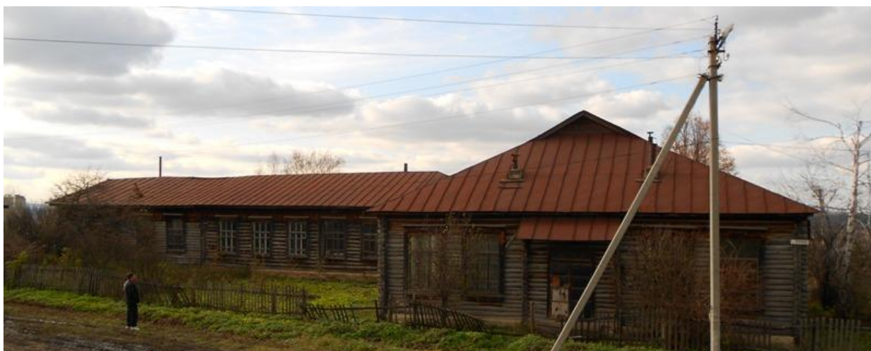
Общий вид на объект по ул. Новая
