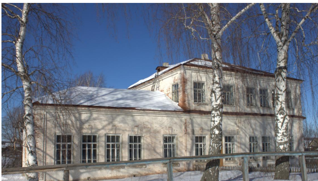
Общий вид на объект с ул. Матросова
