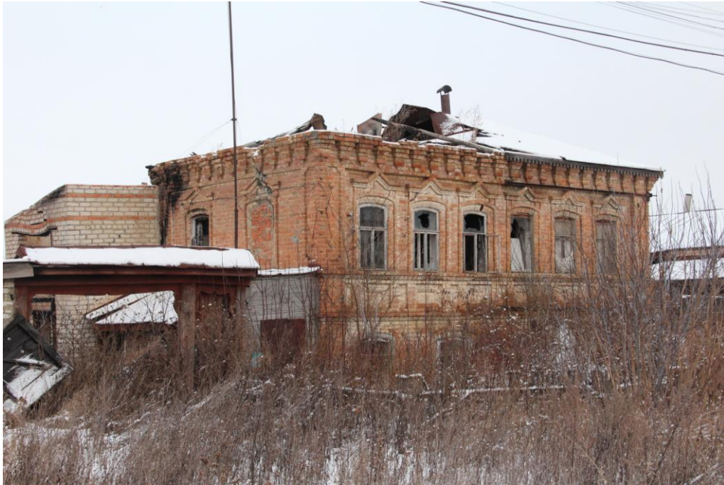
Общий вид на объект с ул. Нижняя
