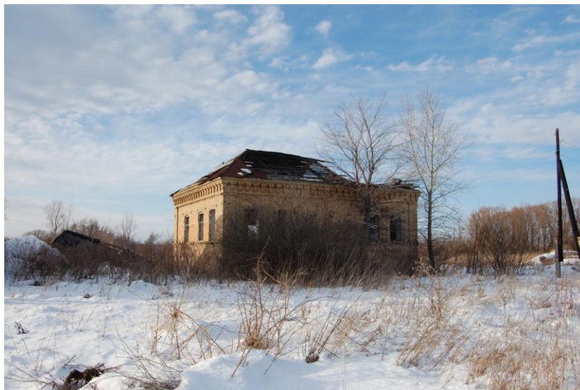
Общий вид на объект
