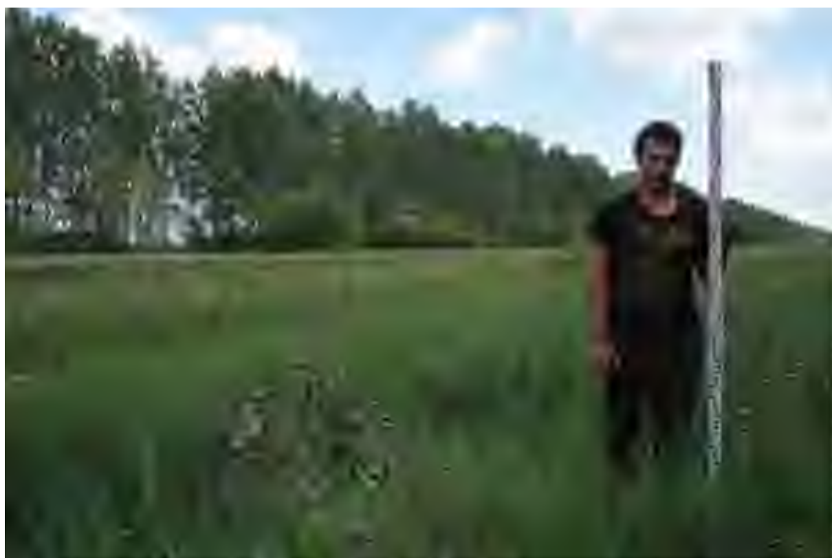
Илл. 29. Капитальный ремонт автомобильной дороги Р-178 Саранск - Сурское - Ульяновск на участке км 135+000 – км 142+000, Карсунский район, Ульяновская область. Шурф 7. Место разбивки шурфа. Вид с З.
