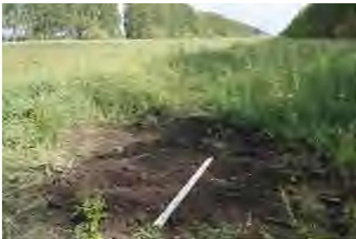
Илл. 34. Капитальный ремонт автомобильной дороги Р-178 Саранск - Сурское - Ульяновск на участке км 135+000 – км 142+000, Карсунский район, Ульяновская область. Шурф 8. Рекультивация. Вид с З.
