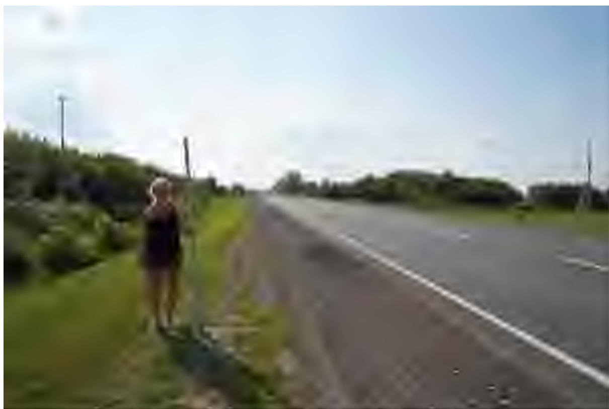
Илл. 5. Капитальный ремонт автомобильной дороги Р-178 Саранск - Сурское - Ульяновск на участке км 135+000 – км 142+000, Карсунский район, Ульяновская область. Вид с В.
