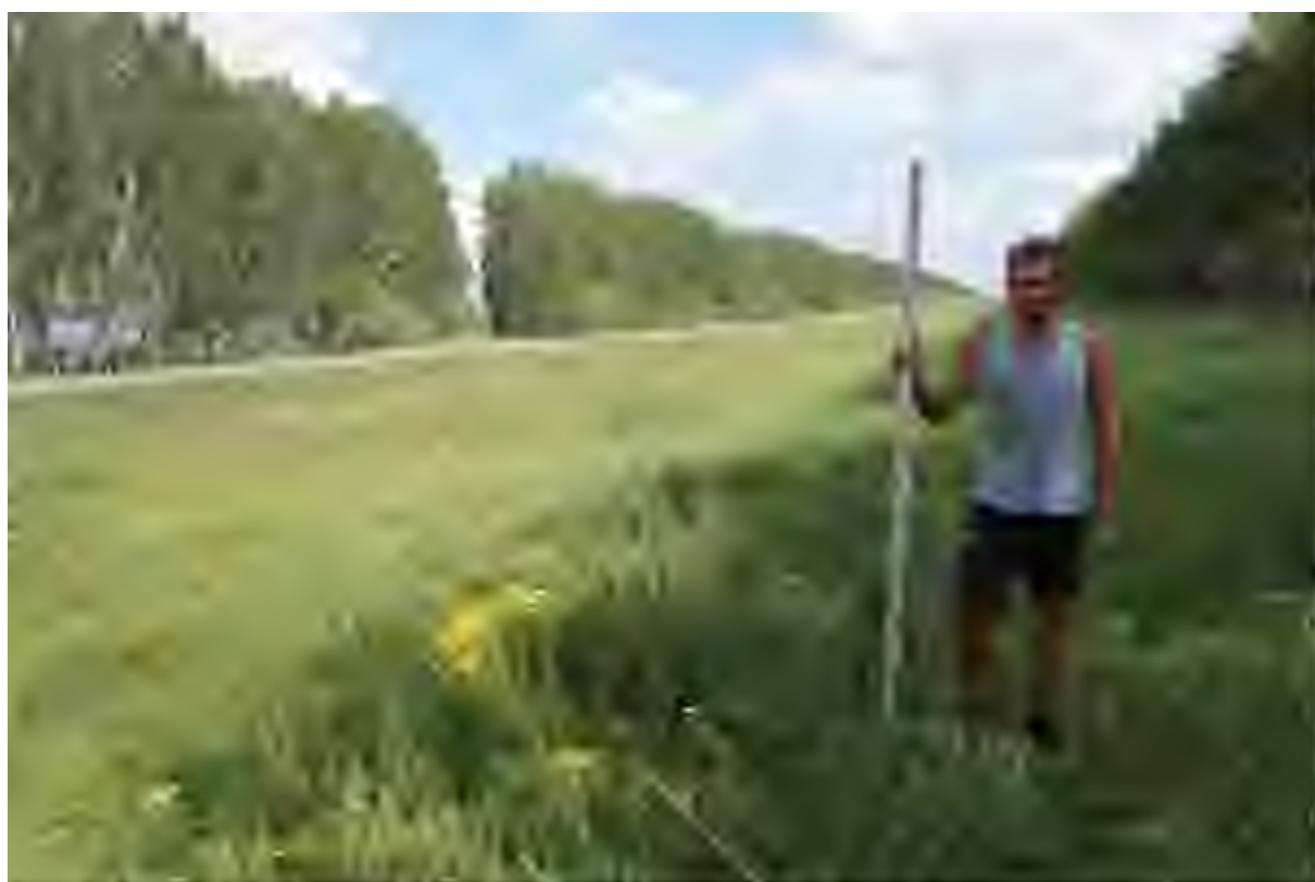
Илл. 32. Капитальный ремонт автомобильной дороги Р-178 Саранск - Сурское - Ульяновск на участке км 135+000 – км 142+000, Карсунский район, Ульяновская область. Шурф 8. Место разбивки шурфа. Вид с 3.
