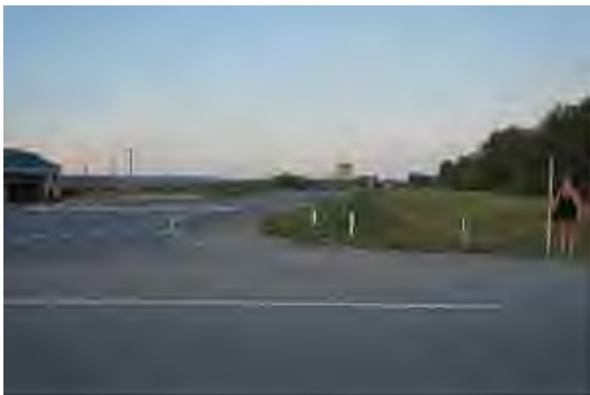
Илл. 9. Капитальный ремонт автомобильной дороги Р-178 Саранск - Сурское - Ульяновск на участке км 135+000 – км 142+000, Карсунский район, Ульяновская область. Вид с З.
