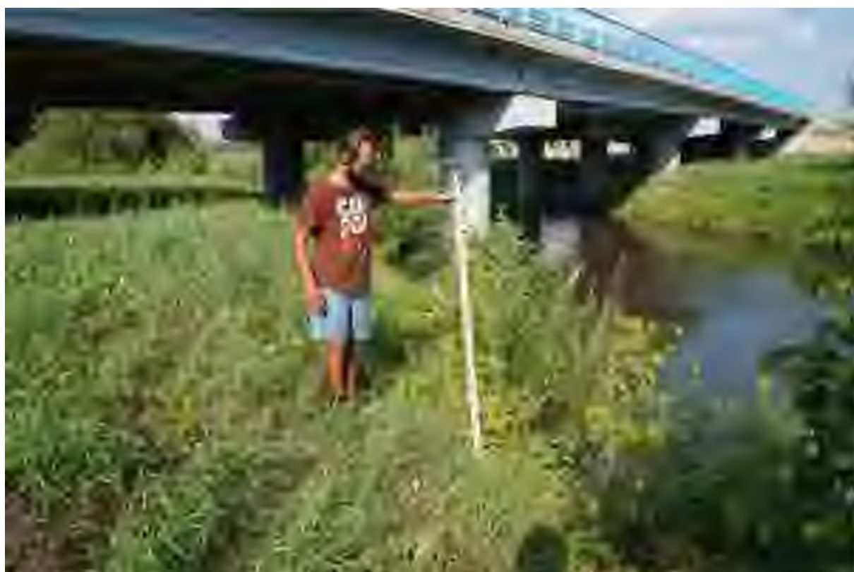
Илл. 13. Капитальный ремонт автомобильной дороги Р-178 Саранск - Сурское - Ульяновск на участке км 135+000 – км 142+000, Карсунский район, Ульяновская область. Шурф-защитка 1. Место разбивки шурфа. Вид с Ю.
