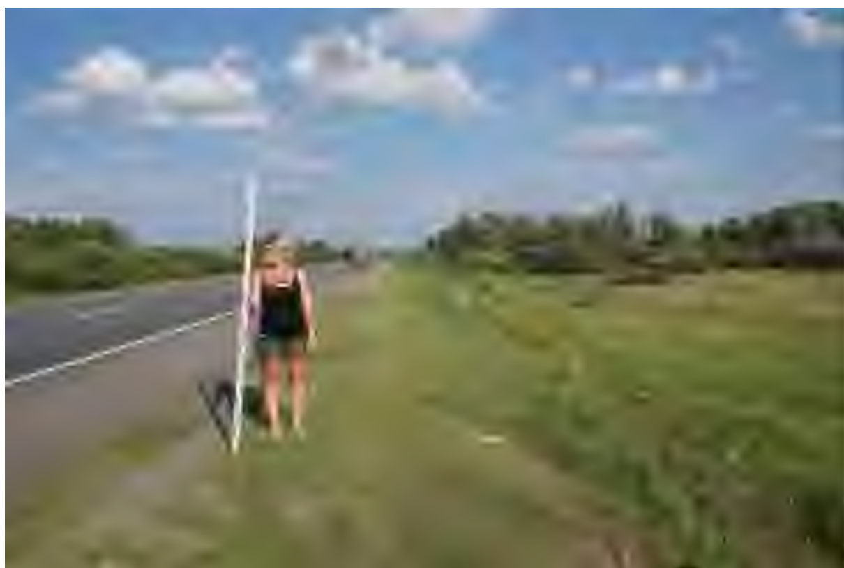
Илл. 6. Капитальный ремонт автомобильной дороги Р-178 Саранск - Сурское - Ульяновск на участке км 135+000 – км 142+000, Карсунский район, Ульяновская область. Вид с З.
