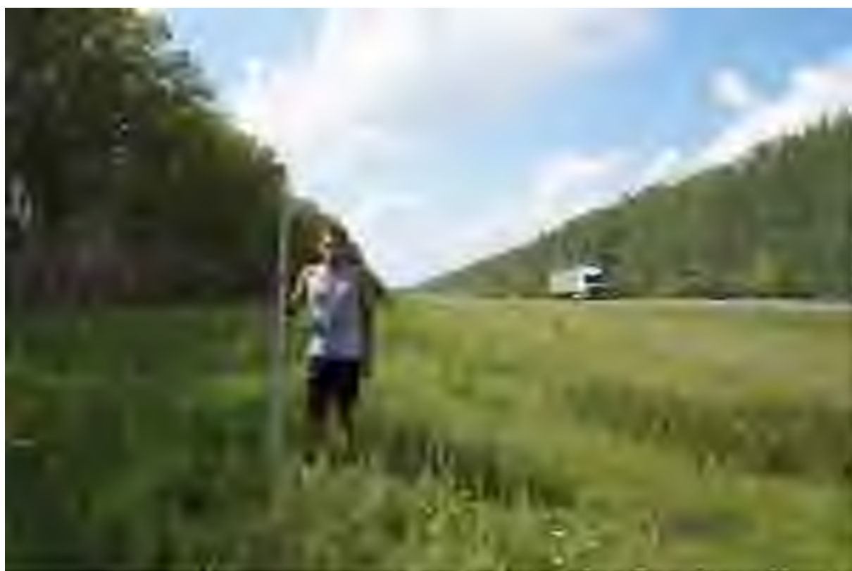
Илл. 11. Капитальный ремонт автомобильной дороги Р-178 Саранск - Сурское - Ульяновск на участке км 135+000 – км 142+000, Карсунский район, Ульяновская область. Вид с 3.
