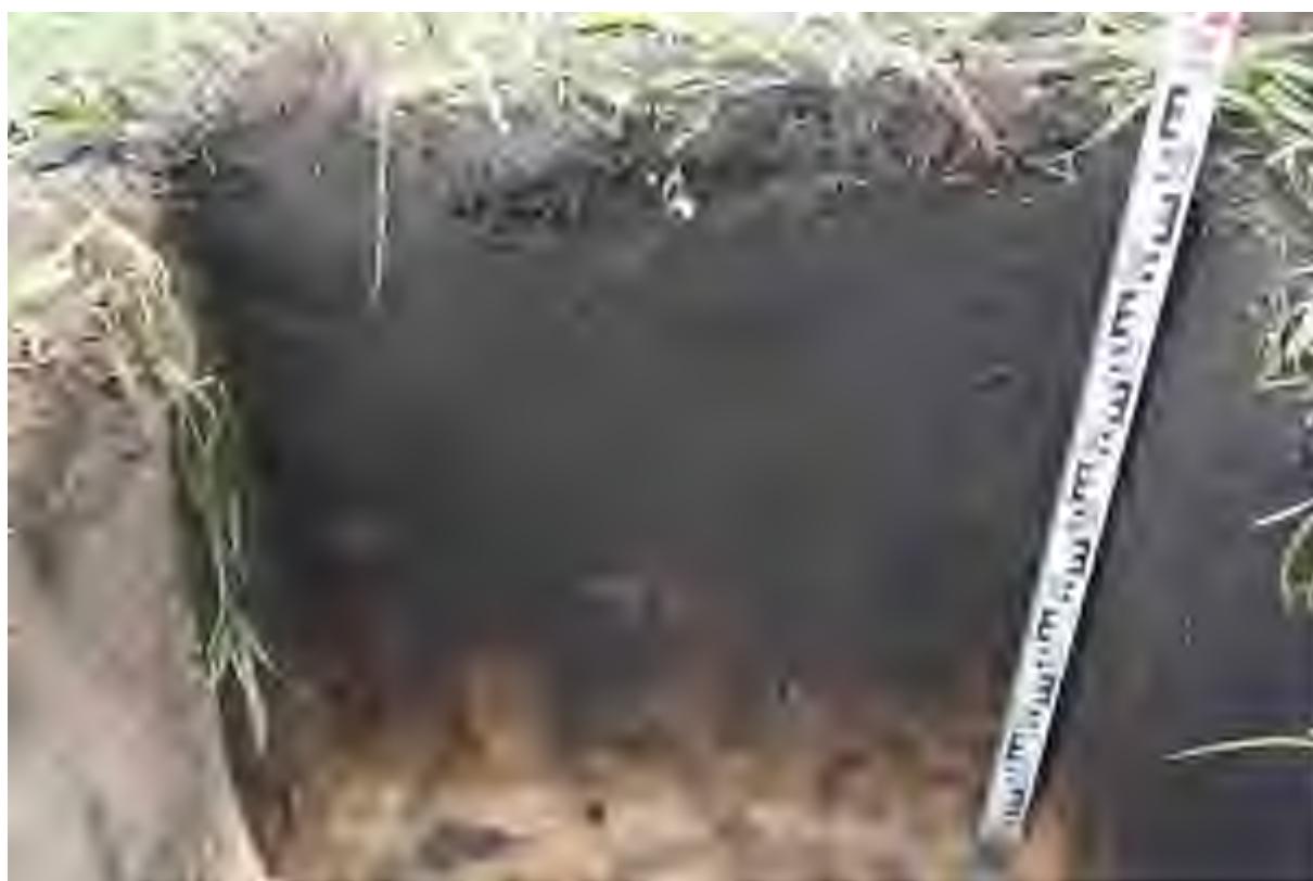
Илл. 30. Капитальный ремонт автомобильной дороги Р-178 Саранск - Сурское - Ульяновск на участке км 135+000 – км 142+000, Карсунский район, Ульяновская область. Шурф 7. Зачистка северного борга шурфа. Вид с Ю.
