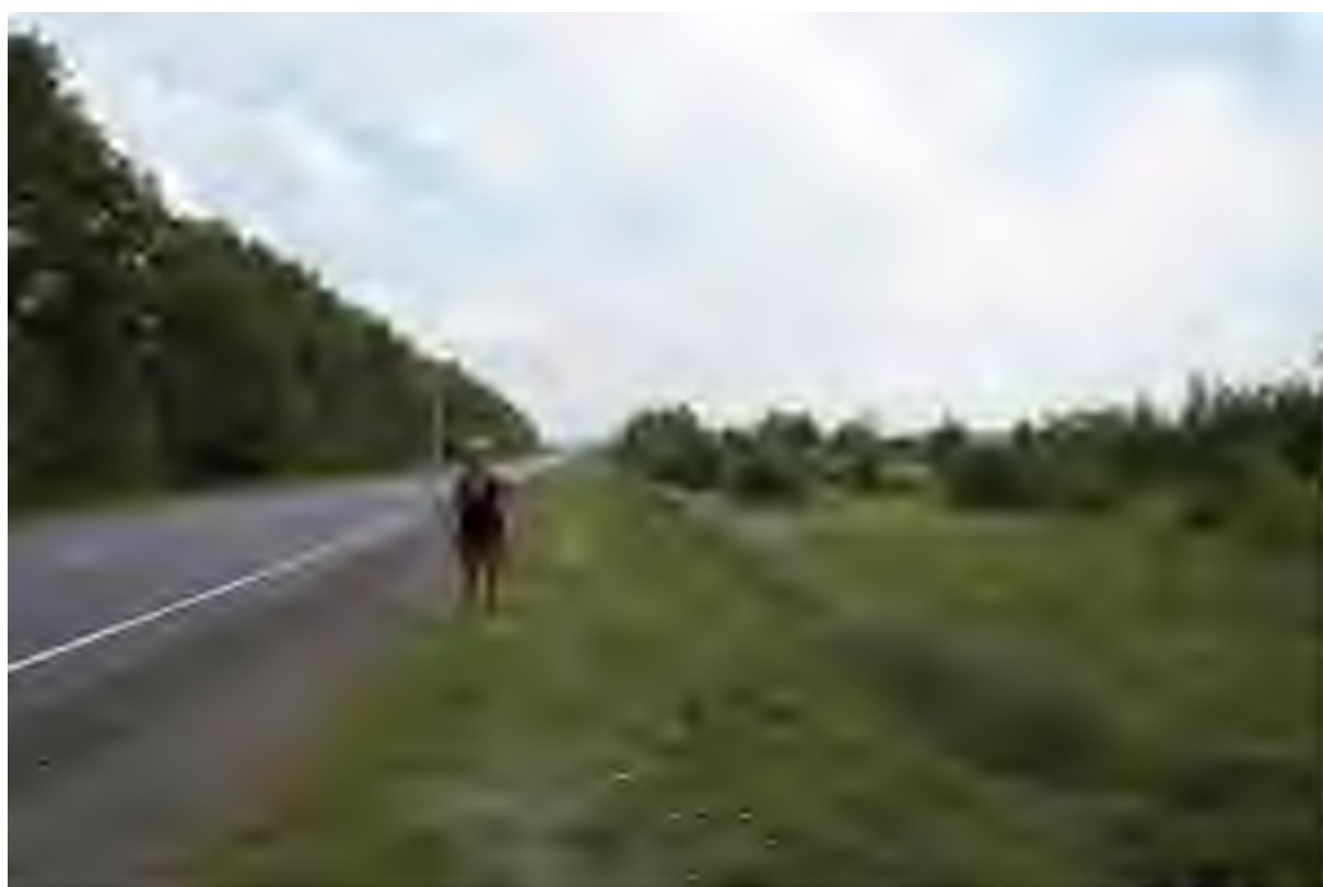
Илл. 4. Капитальный ремонт автомобильной дороги Р-178 Саранск - Сурское - Ульяновск на участке км 135+000 – км 142+000, Карсунский район, Ульяновская область. Вид с З.
