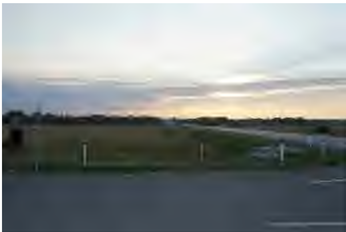
Илл. 8. Капитальный ремонт автомобильной дороги Р-178 Саранск - Сурское - Ульяновск на участке км 135+000 – км 142+000, Карсунский район, Ульяновская область. Вид с В.
