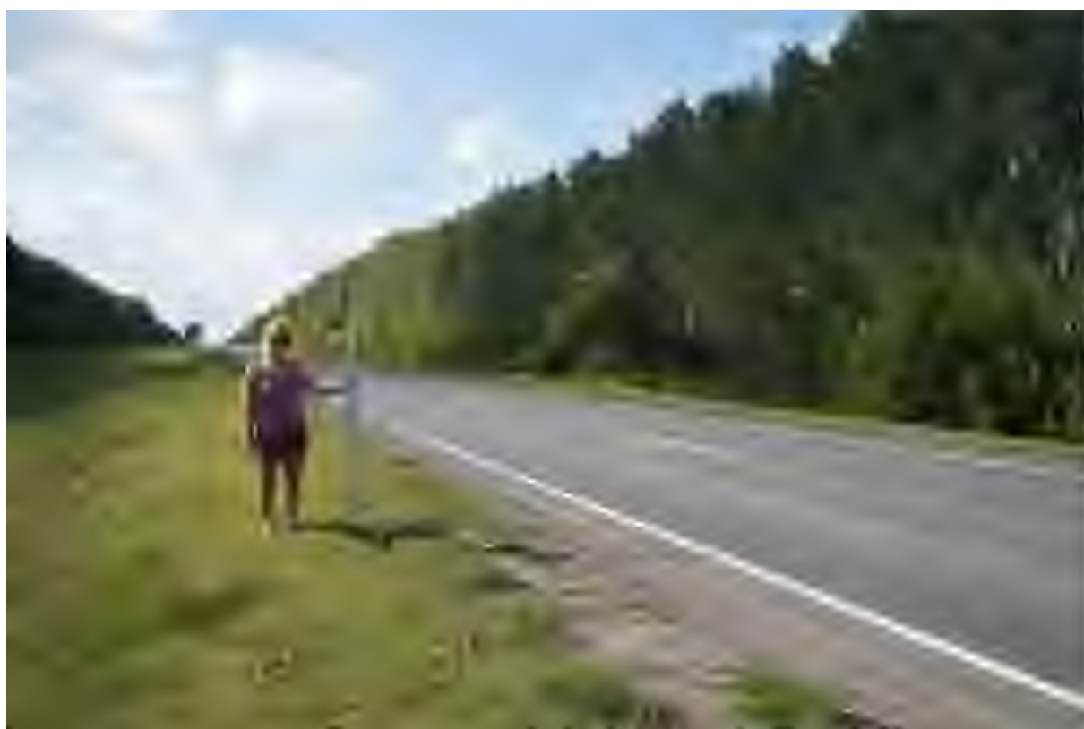
Илл. 12. Капитальный ремонт автомобильной дороги Р-178 Саранск - Сурское - Ульяновск на участке км 135+000 – км 142+000, Карсунский район, Ульяновская область. Вид с 3.
