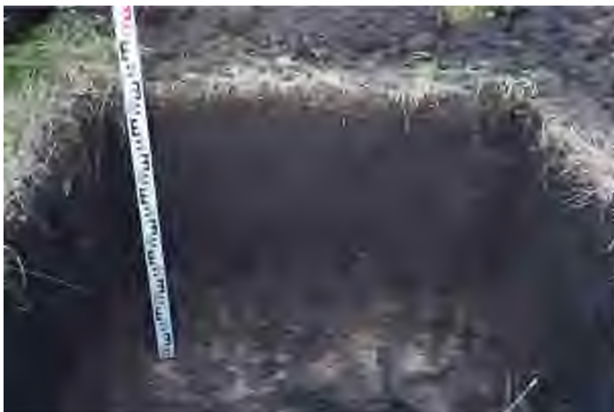
Илл. 27. Капитальный ремонт автомобильной дороги Р-178 Саранск - Сурское - Ульяновск на участке км 135+000 – км 142+000, Карсунский район, Ульяновская область. Шурф 6. Зачистка северного борта шурфа. Вид с Ю.
