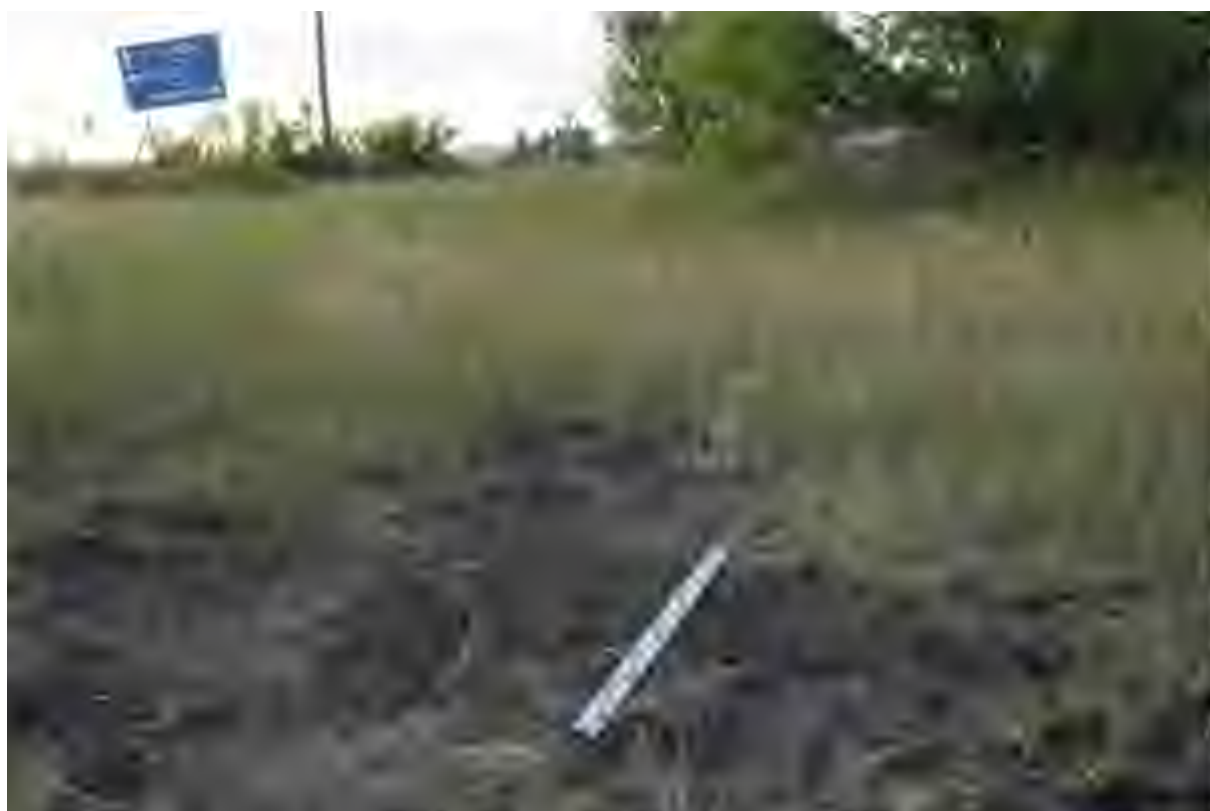
Илл. 25. Капитальный ремонт автомобильной дороги Р-178 Саранск - Сурское - Ульяновск на участке км 135+000 – км 142+000, Карсунский район, Ульяновская область. Шурф 5. Рекультивация. Вид с Ю.
