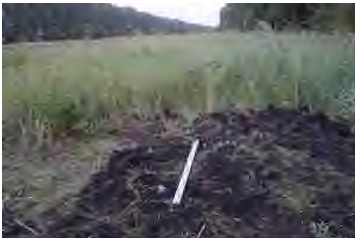
Илл. 28. Капитальный ремонт автомобильной дороги Р-178 Саранск - Сурское - Ульяновск на участке км 135+000 – км 142+000, Карсунский район, Ульяновская область. Шурф 6. Рекультивация. Вид с З.
