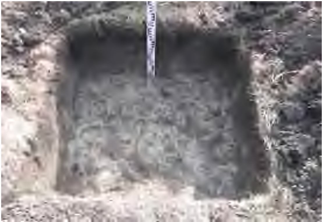
Рис. 9. Объект: «Высоконапорный водовод от задвижки скважины № 31 до задвижки скважины № 25 Варварского нефтяного месторождения» в Николаевском районе Ульяновской области. Общий вид с Ю на шурф 1.
