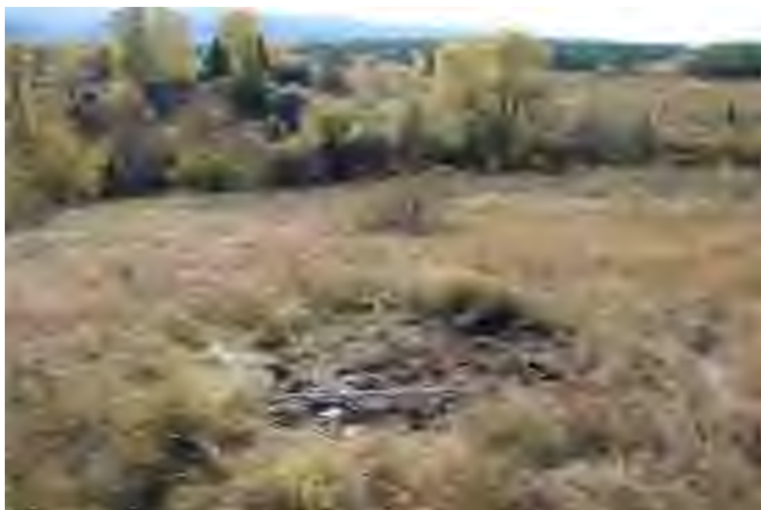
Рис. 92. Объект: «Газопровод межпоселковый от ГРС р.п. Тереньга размещения объекта: «Газопровод межпоселковый от с. Коржевка – с. Проломиха – с. Чамзинка Инзенского района Ульяновской области (код стройки 73/1521-1)». Вид с Ю на рекультивацию шурфа 16.
