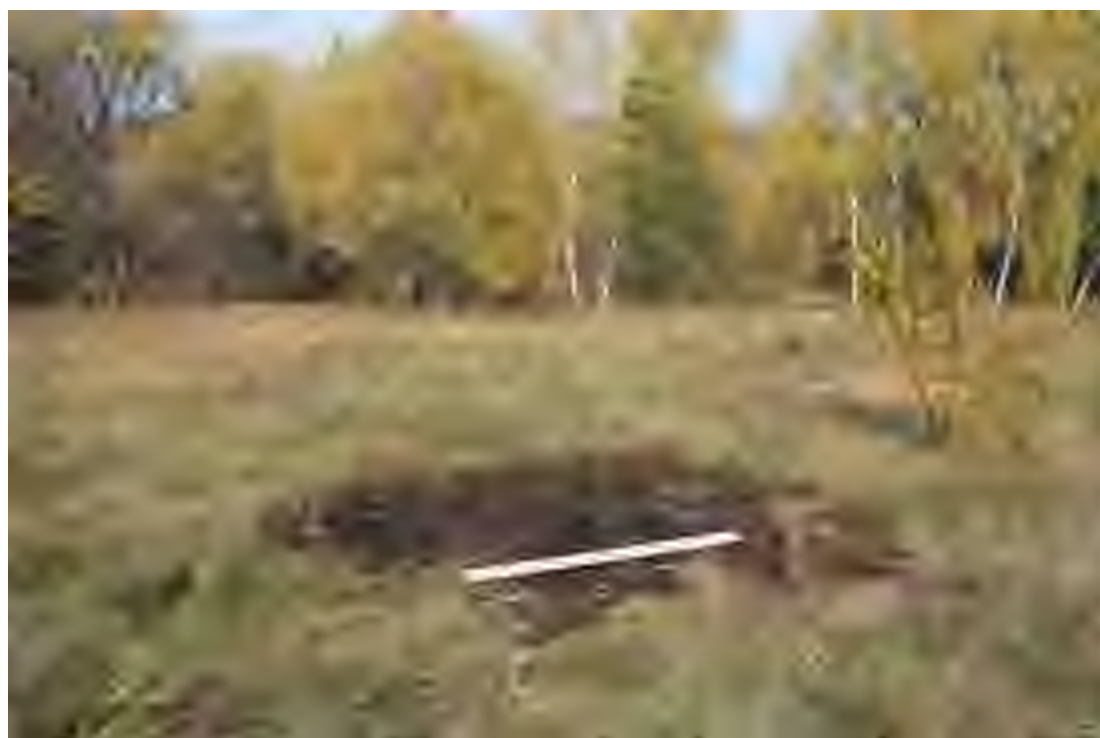
Рис. 96. Объект: «Газопровод межпоселковый от ГРС р.п. Тереньга размещения объекта: «Газопровод межпоселковый от с. Коржевка – с. Проломиха – с. Чамзинка Инзенского района Ульяновской области (код стройки 73/1521-1)». Вид с С на рекультивацию шурфа 17.
