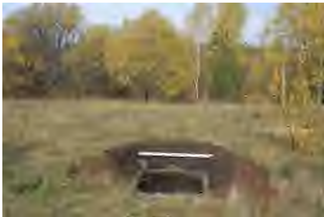
Рис. 95. Объект: «Газопровод межпоселковый от ГРС р.п. Тереньга размещения объекта: «Газопровод межпоселковый от с. Коржевка – с. Проломиха – с. Чамзинка Инзенского района Ульяновской области (код стройки 73/1521-1)». Вид с С на шурф 17.
