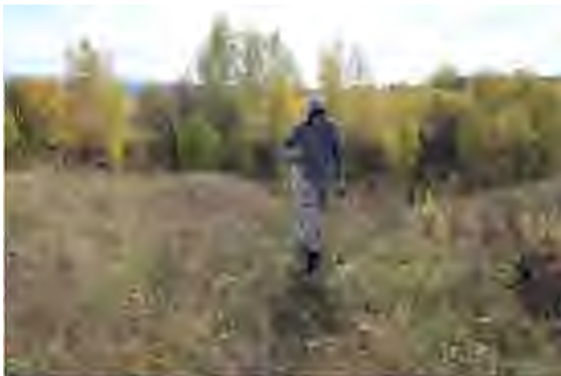
Рис. 97. Объект: «Газопровод межпоселковый от ГРС р.п. Тереньга размещения объекта: «Газопровод межпоселковый от с. Коржевка – с. Проломиха – с. Чамзинка Инзенского района Ульяновской области (код стройки 73/1521-1)». Вид с Ю на разбивку шурфа 18.
