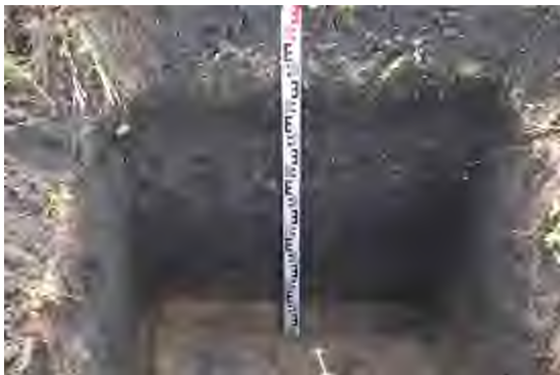
Рис. 98. Объект: «Газопровод межпоселковый от ГРС р.п. Тереньга размещения объекта: «Газопровод межпоселковый от с. Коржевка – с. Проломиха – с. Чамзинка Инзенского района Ульяновской области (код стройки 73/1521-1)». Вид с Ю на стенку шурфа 18.
