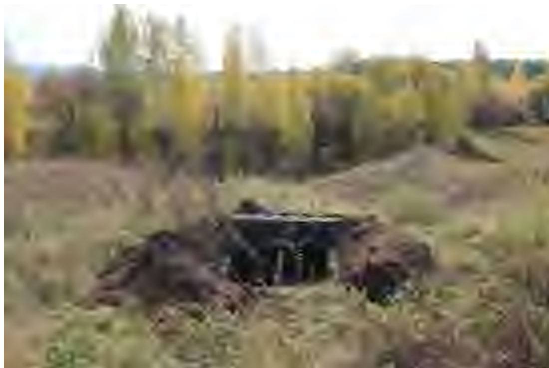
Рис. 99. Объект: «Газопровод межпоселковый от ГРС р.п. Тереньга размещения объекта: «Газопровод межпоселковый от с. Коржевка – с. Проломиха – с. Чамзинка Инзенского района Ульяновской области (код стройки 73/1521-1)». Вид с Ю на шурф 18.
