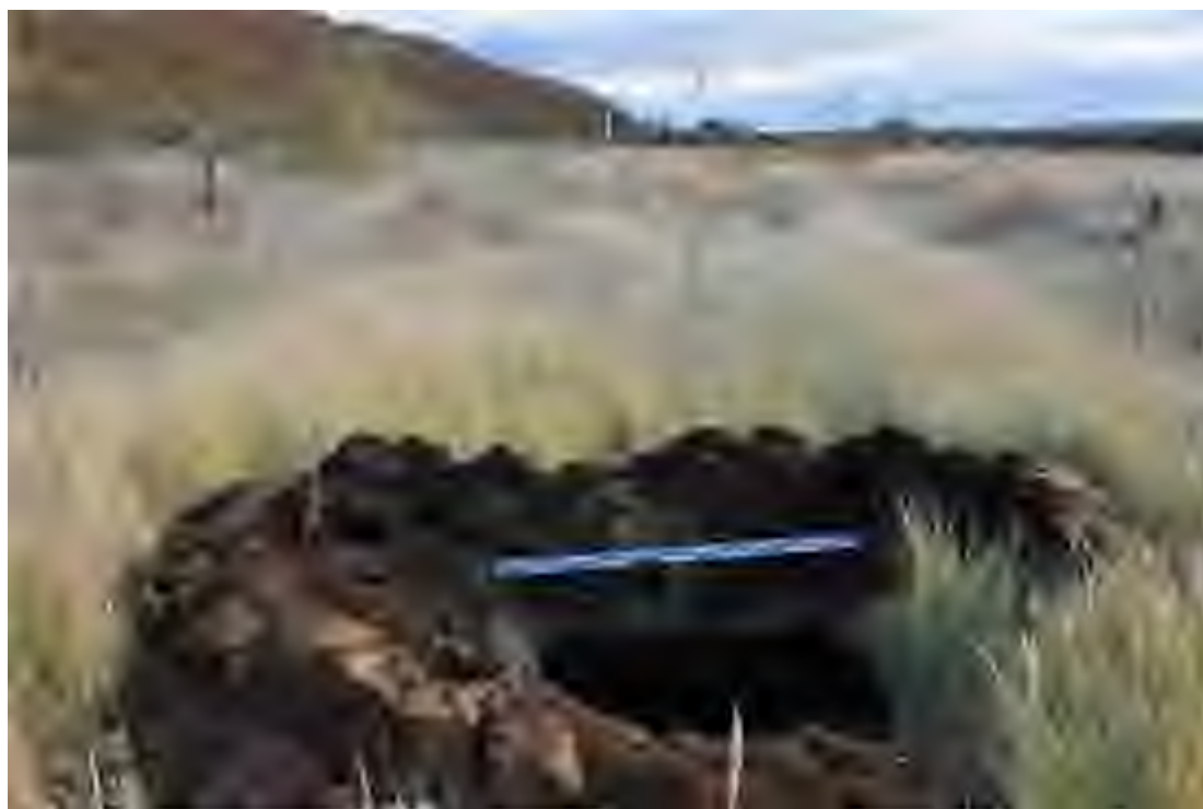
Рис. 27. Объект «Рекультивация полигона ТКО в районе села Красный Яр Заволжского района г. Ульяновска, Ульяновской области». Вид с 3 на шурф 4.
