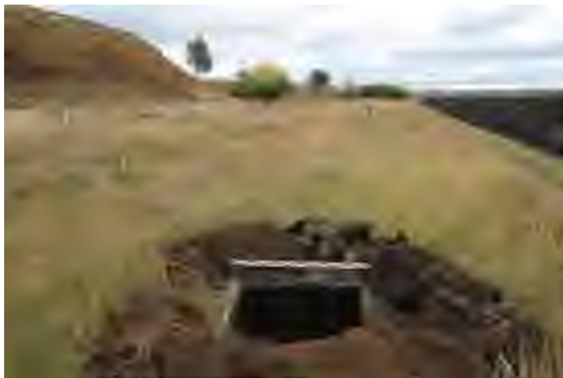
Рис. 31. Объект «Рекультивация полигона ТКО в районе села Красный Яр Заволжского района г. Ульяновска, Ульяновской области». Вид с 3 на шурф 5.
