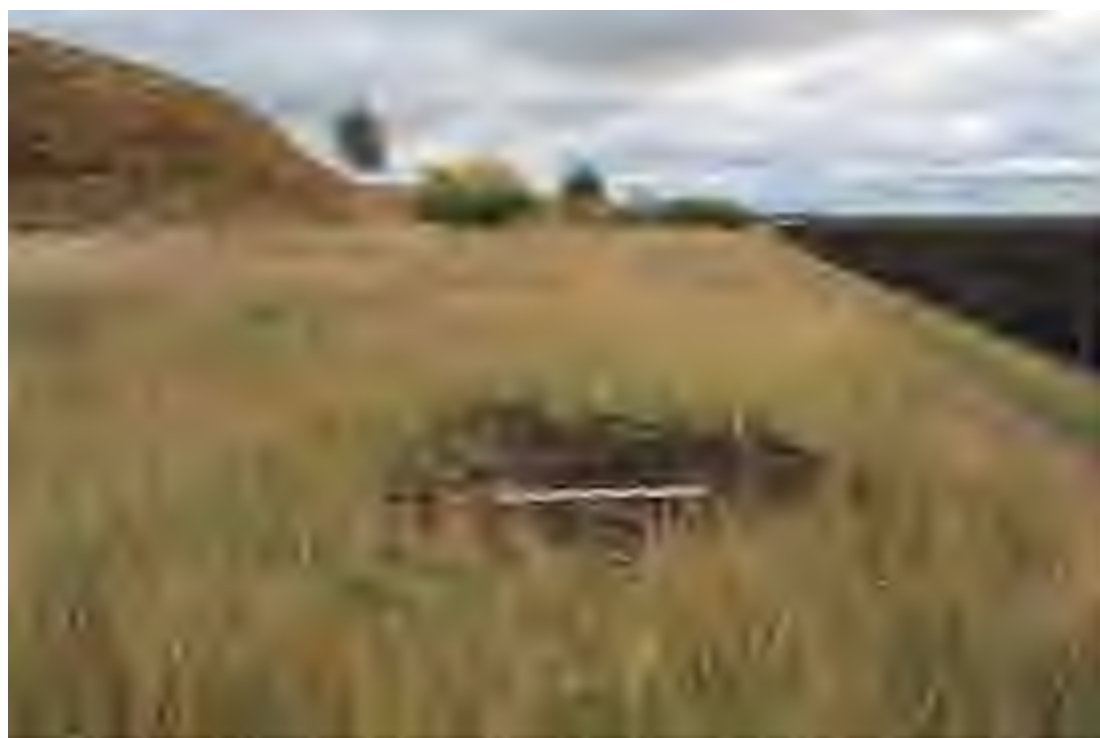
Рис. 32. Объект «Рекультивация полигона ТКО в районе села Красный Яр Заволжского района г. Ульяновска, Ульяновской области». Вид с 3 на рекультивацию шурфа 5.
