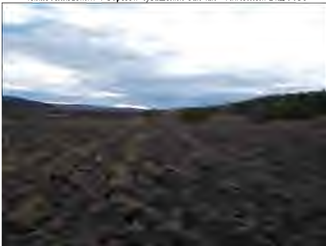
Рис.88 Земельный участок, отводимый под строительство объекта: «Газопровод межпоселковый...». Отрезок Чувашский Сайман – Ахметлей. Вид с СВ
