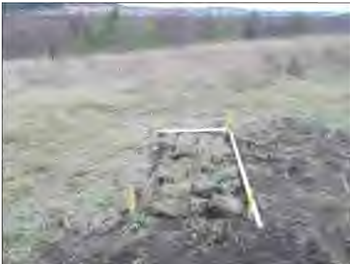
Рис.102. Земельный участок, отводимый под строительство объекта: «Газопровод межпоселковый...». Рекультивированная площадка шурфа №18. Вид с С
