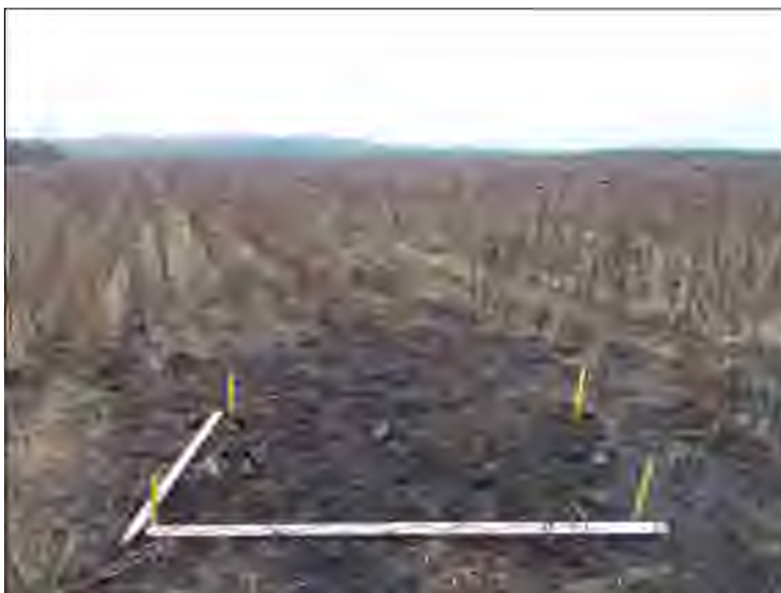
Рис. 115. Земельный участок, отводимый под строительство объекта: «Газопровод межпоселковый...». Рекультивированная площадка шурфа №19. Вид с З
