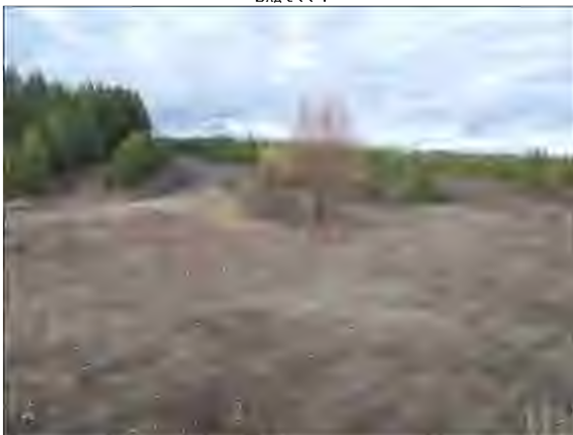
Рис.82. Земельный участок, отводимый под строительство объекта: «Газопровод межпоселковый. » Отрезок Чувашский Сайман – Ахметлей. Переход трассы через овраг. Вид с ЮЮВ
