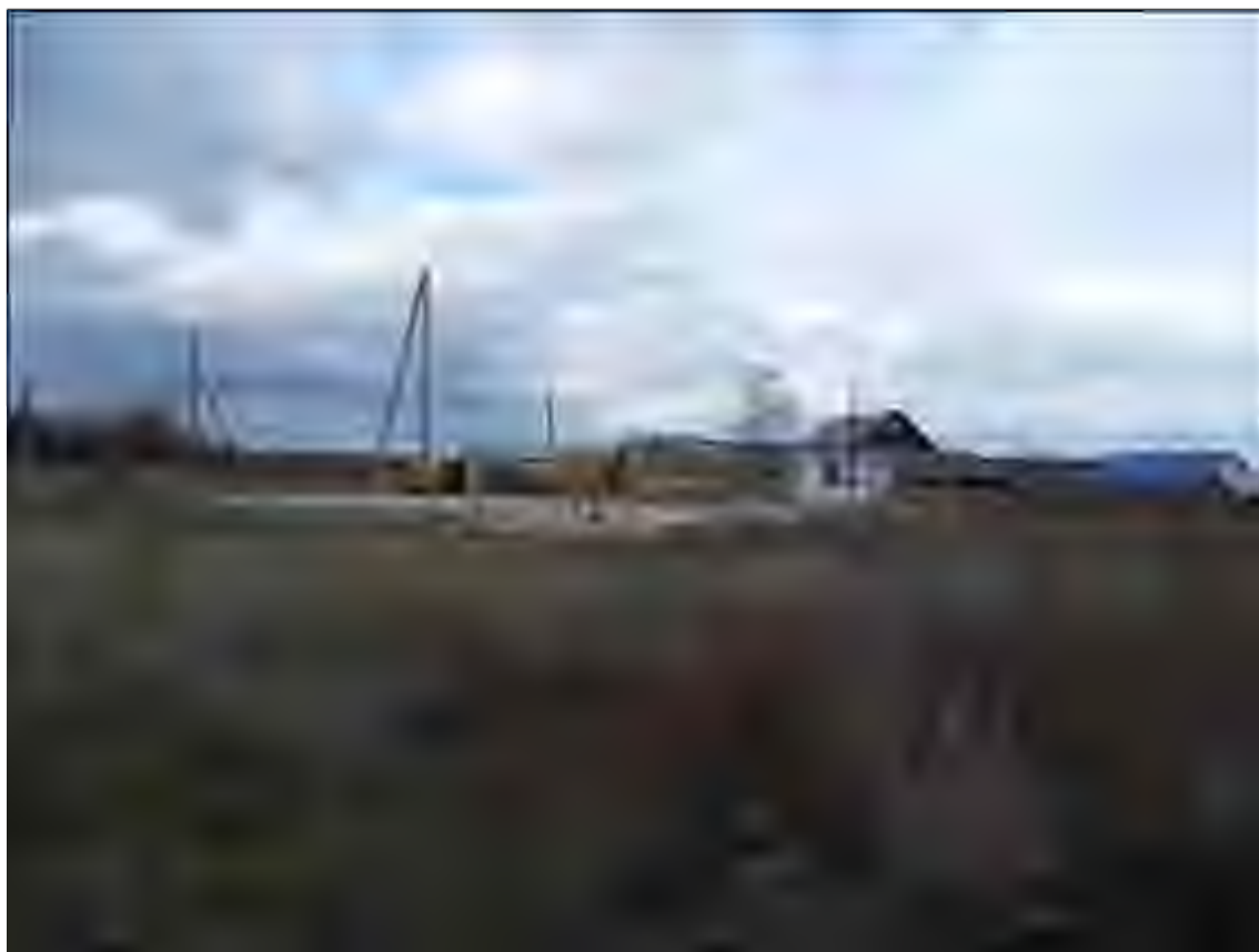
Рис.239. Земельный участок, отводимый под строительство объекта: «Газопровод межпоселковый...». Отрезок Чувашский Сайман – Топорнино. Финальный пункт трассы. Вид с ЮЮВ
