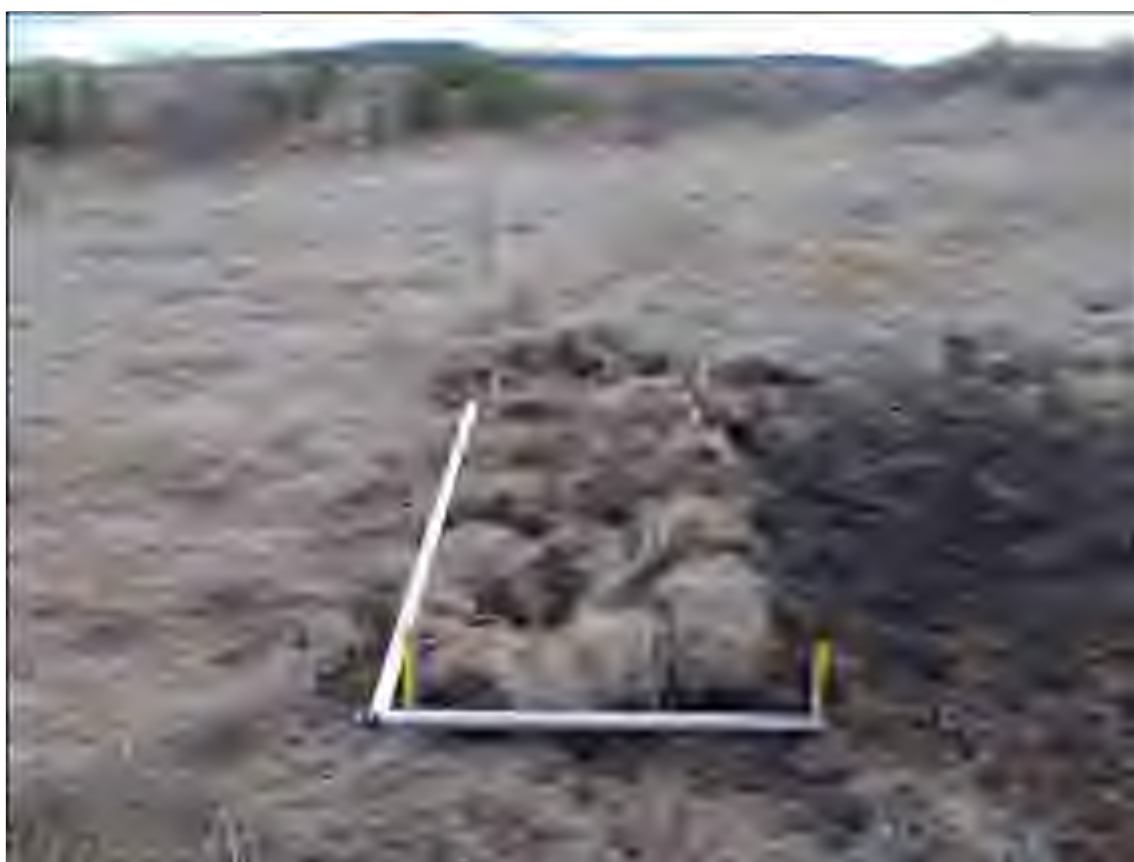
Рис.188. Земельный участок, отводимый под строительство объекта: «Газопровод межпоселковый...». Рекультивированная площадка шурфа №19. Вид с С
