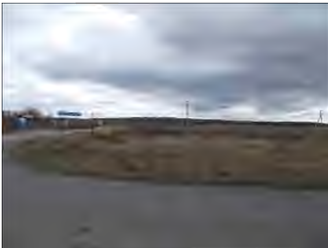
Рис.231. Земельный участок, отводимый под строительство объекта: «Газопровод межпоселковый...». Отрезок Чувашский Сайман – Топорнино. Отрезок трассы у заборной с.Топорнино. Вид с ЗСЗ
