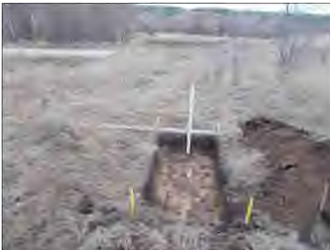
Рис.198. Земельный участок, отводимый под строительство объекта: «Газопровод межпоселковый...». Реконструктивный шурф №13. Вид с Ю
