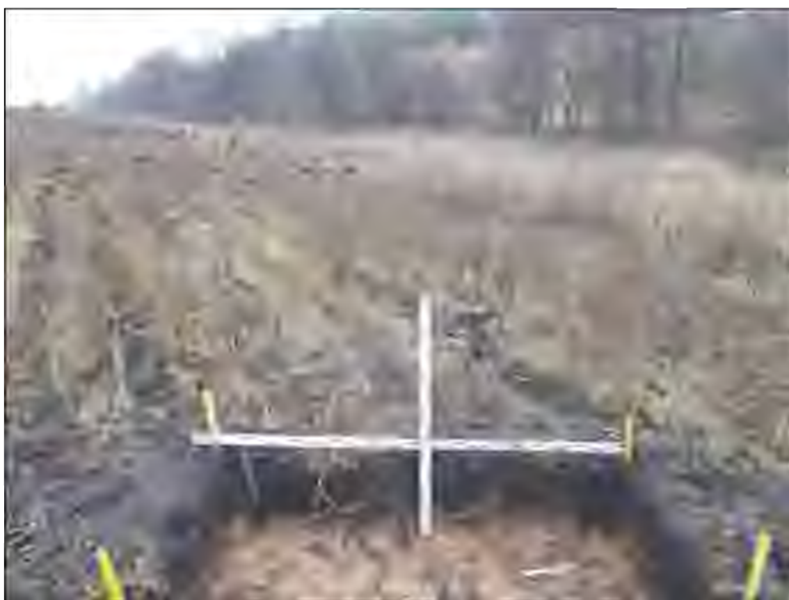
Рис. 111. Земельный участок, отводимый под строительство объекта: «Газопровод межпоселковый. . .». Рекогносцировочный шурф №19. Вид с В
