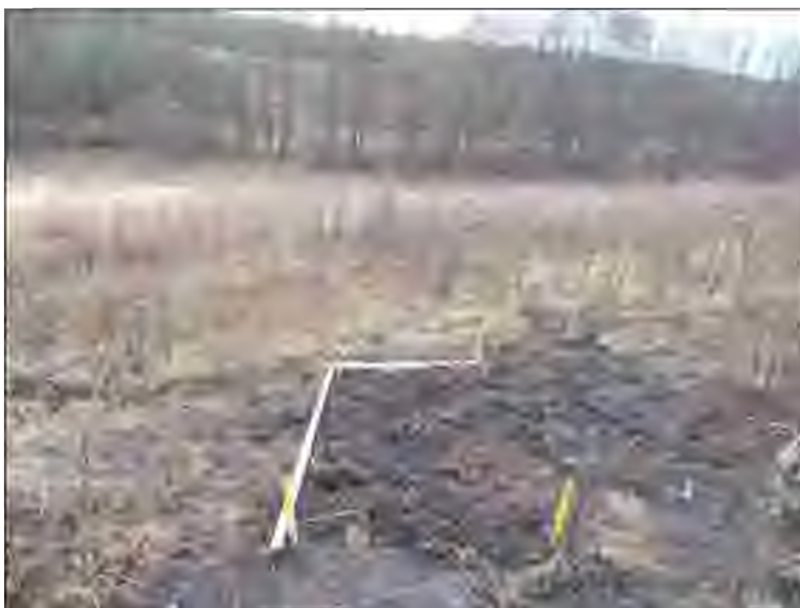
Рис.113. Земельный участок, отводимый под строительство объекта: «Газопровод межпоселковый...». Реконструктивная площадка шурфа №19. Вид с Ю
