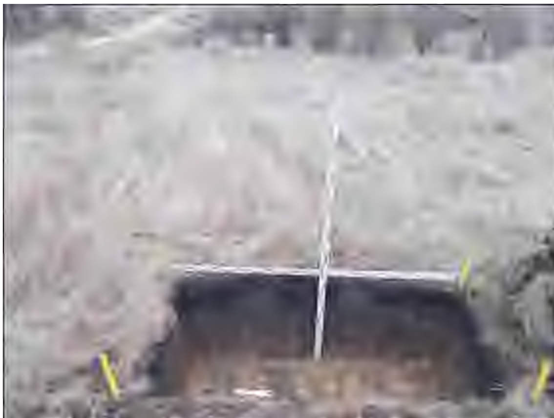
Рис.184. Земельный участок, отводимый под строительство объекта: «Газопровод межпоселковый...». Реконсципровочный шурф №12. Вид с 3
