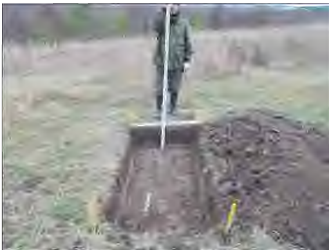
Рис.100. Земельный участок, отводимый под строительство объекта: «Газопровод межпоселковый. ...». Реконсципровочный шурф №18. Вид с 3
