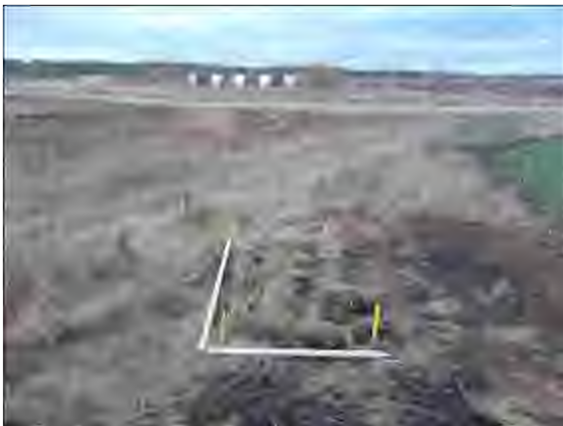
Рис 227. Земельный участок, отводимый под строительство объекта: «Газопровод межпоселковый...» Рекультивированная площадка шурфа №15. Вид с Ю
