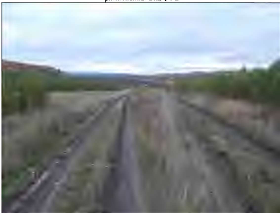
Рис.92. Земельный участок, отводимый под строительство объекта: «Газопровод межпоселковый...». Отрезок Чувашский Сайман – Ахметлей. Отрезок на левом берегу р.Митлейка. Вид с ЮЗ
