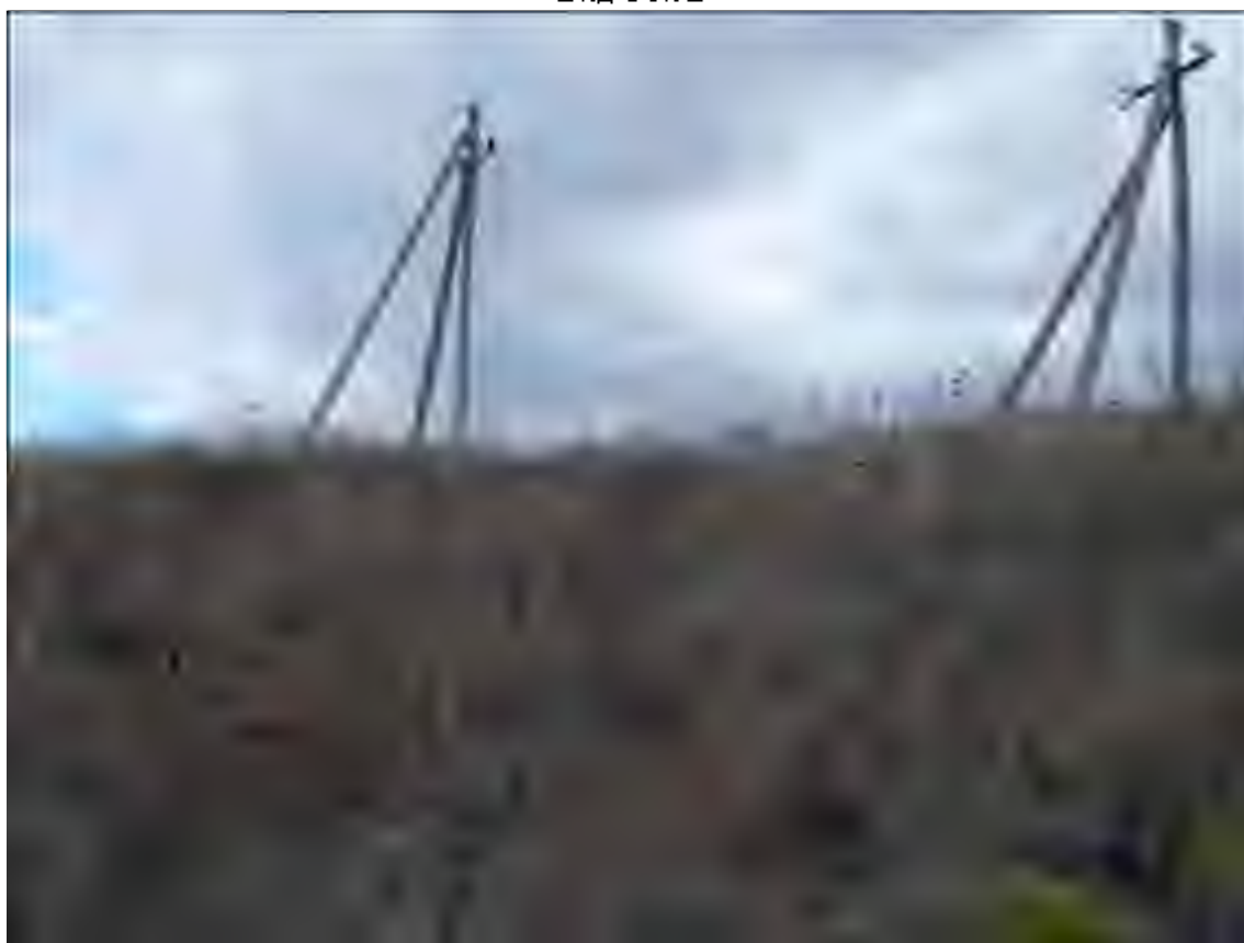
Рис.151. Земельный участок, отводимый под строительство объекта: «Газопровод межпоселковый...» Место закладки рекогносцировочного шурфа (стратиграфического разреза) №8. Вид с ЮЗ
