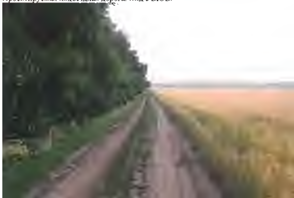
Рис. 18. Объект «Поисковая скважина №1 Южно-Кудряшовской структуры». Проектируемая подъездная дорога. Вид с ЗСЗ.
