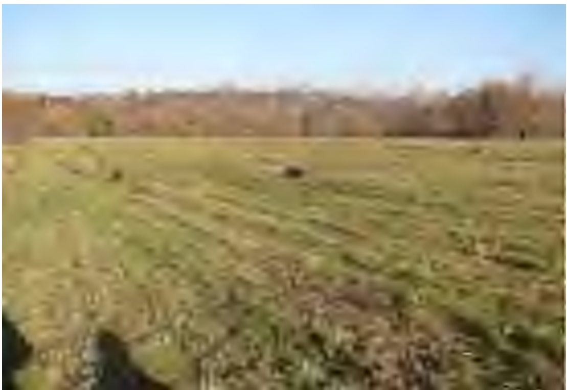
Рис. 6. Объект: «Высоконапорный водовод от задвижки скважины № 21 до задвижки скважины № 8 Репьевского нефтяного месторождения» в Новоспасском районе Ульяновской области. Вид с ЮВ на конечный этап трассы водовода.
