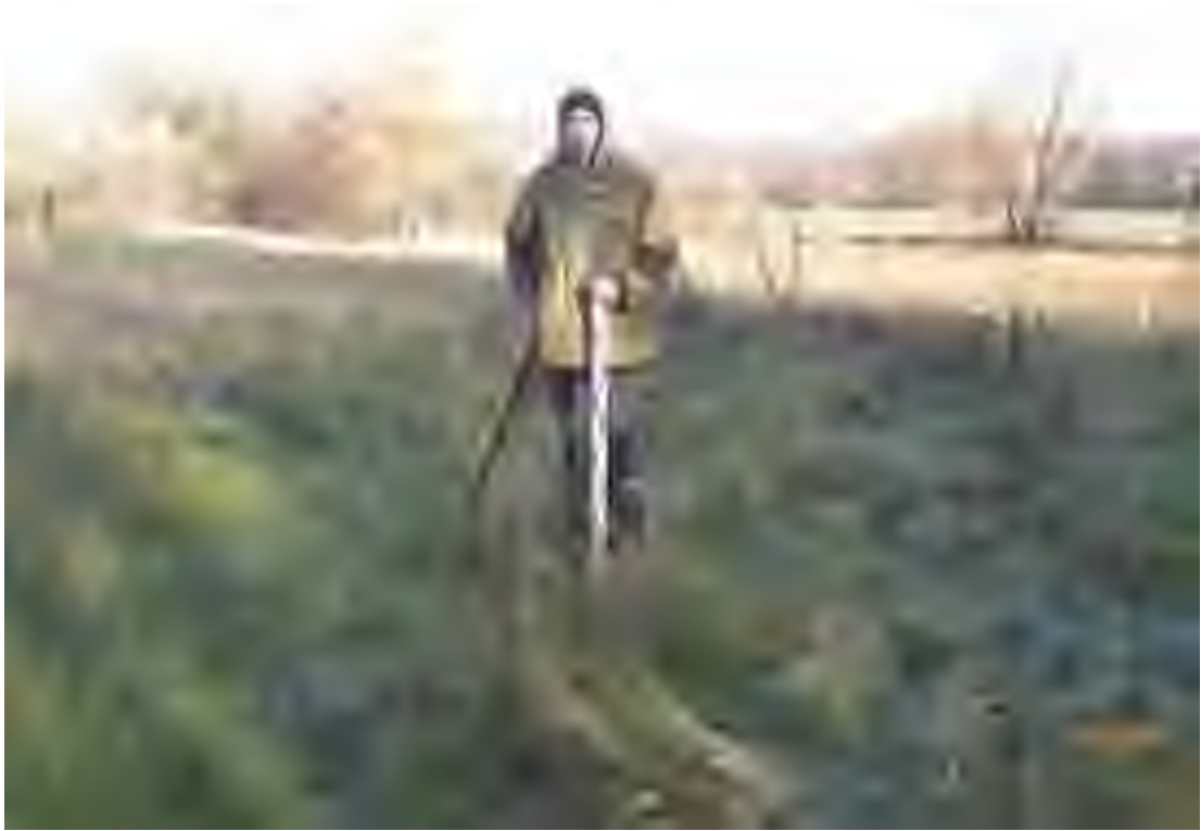
Рис. 7. Объект: «Высоконапорный водовод от задвижки скважины № 21 до задвижки скважины № 8 Реньевского нефтяного месторождения» в Новоспасском районе Ульяновской области. Вид с Ю на разбивку шурфа 1.
