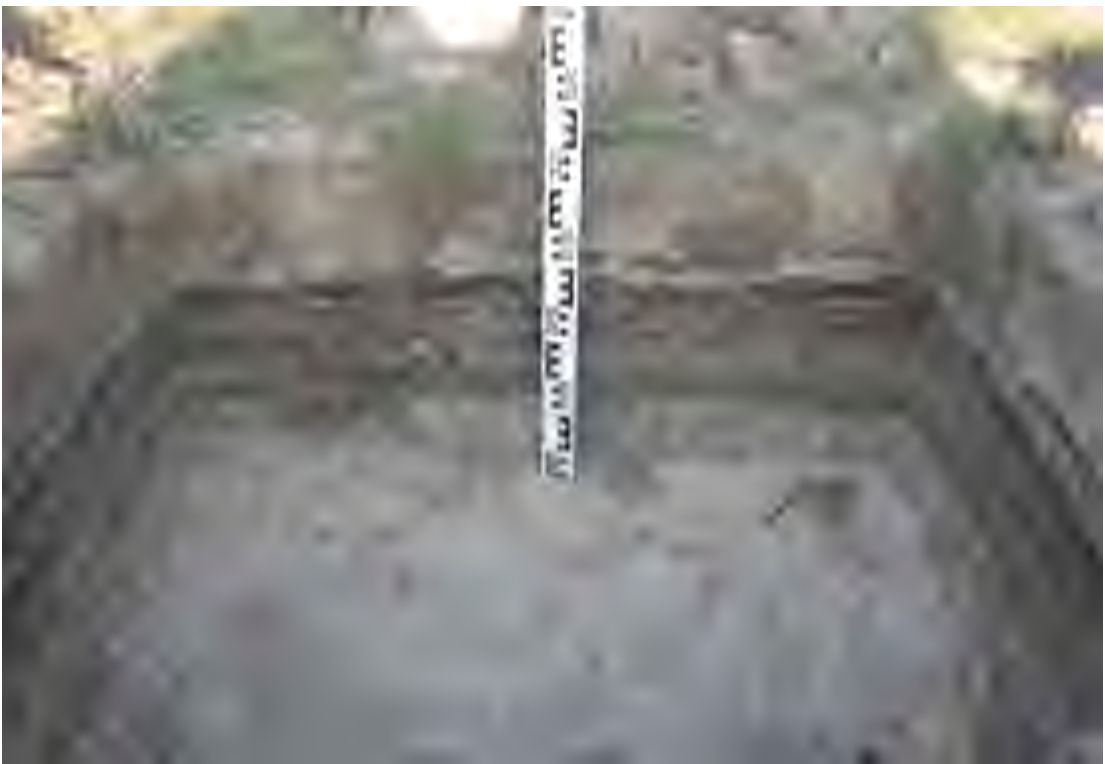
Рис. 12. Объект: «Высоконапорный водовод от задвижки скважины № 21 до задвижки скважины № 8 Репьевского нефтяного месторождения» в Новоспасском районе Ульяновской области. Вид на северную стенку шурфа 2.
