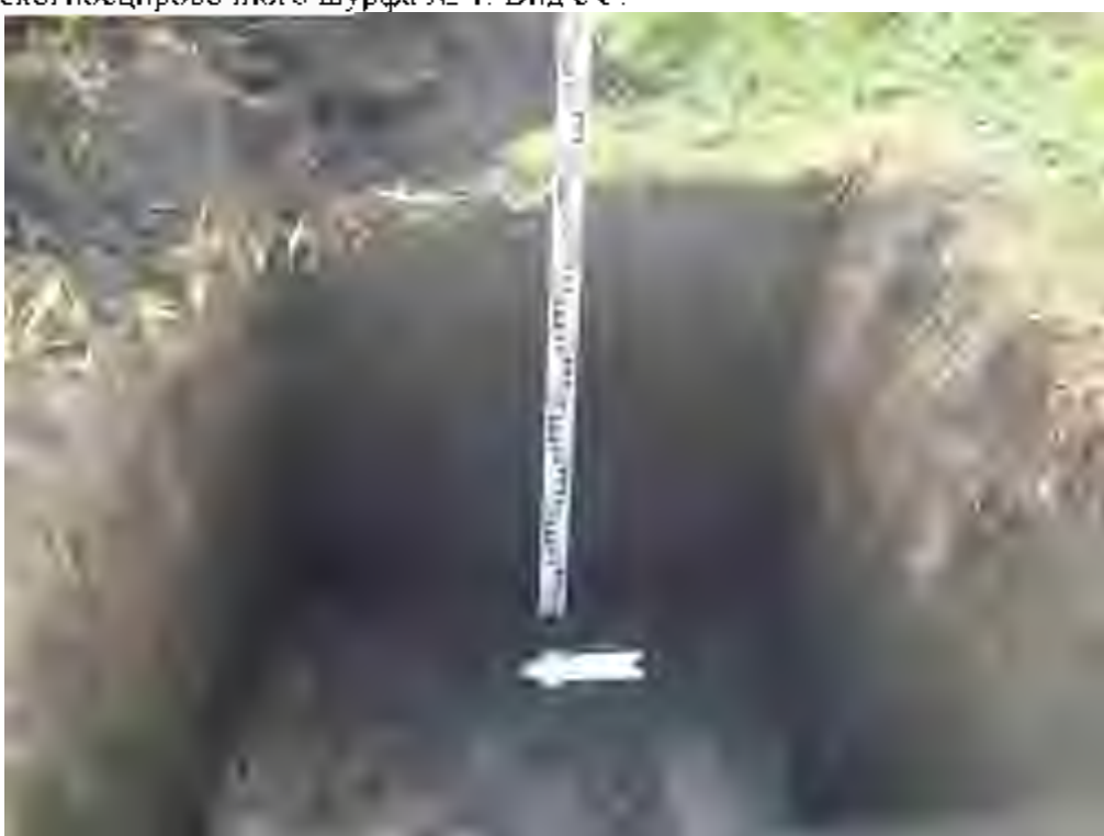
Рис. 13. Объект «Капитальный ремонт моста через реку Крака на км 110+400 автодороги Р-178 Саранск-Сурское-Ульяновск» в Сурском районе Ульяновской области». Западная стенка рекогносцировочного шурфа № 1. Вид с В.
