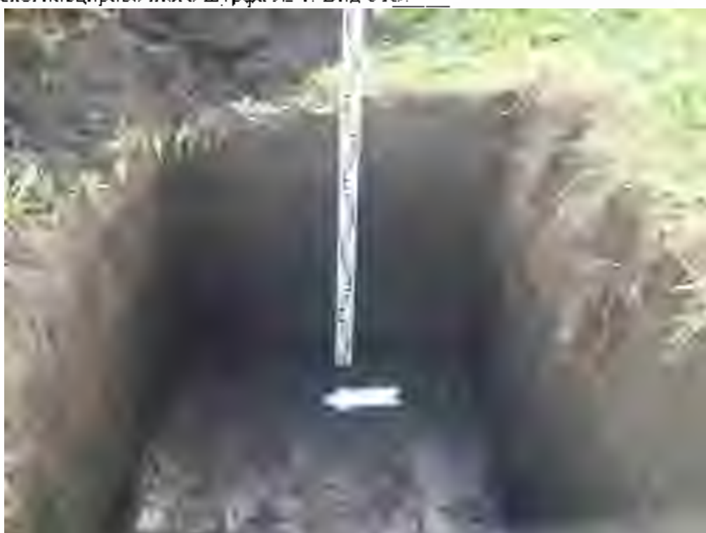
Рис. 11. Объект «Капитальный ремонт моста через реку Крака на км 110+400 автодороги Р-178 Саранск-Сурское-Ульяновск» в Сурском районе Ульяновской области». Восточная стенка рекогносцировочного шурфа № 1. Вид с З.
