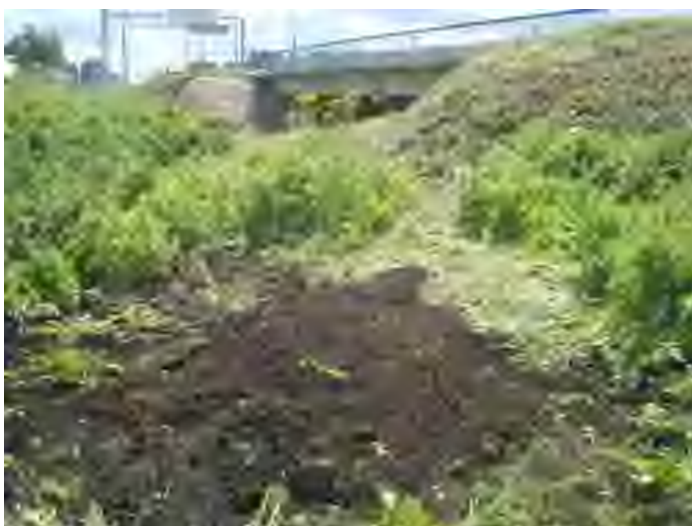
Рис. 14. Объект «Капитальный ремонт моста через реку Крака на км 110+400 автодороги Р-178 Саранск-Сурское-Ульяновск» в Сурском районе Ульяновской области». Рекультивация рекогносцировочного шурфа № 1. Вид с З.
