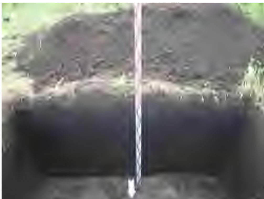
Рис. 18. Объект «Капитальный ремонт моста через реку Крака на км 110+400 автодороги Р-178 Саранск-Сурское-Ульяновск» в Сурском районе Ульяновской области». Южная стенка рекогносцировочного шурфа № 2. Вид с С.
