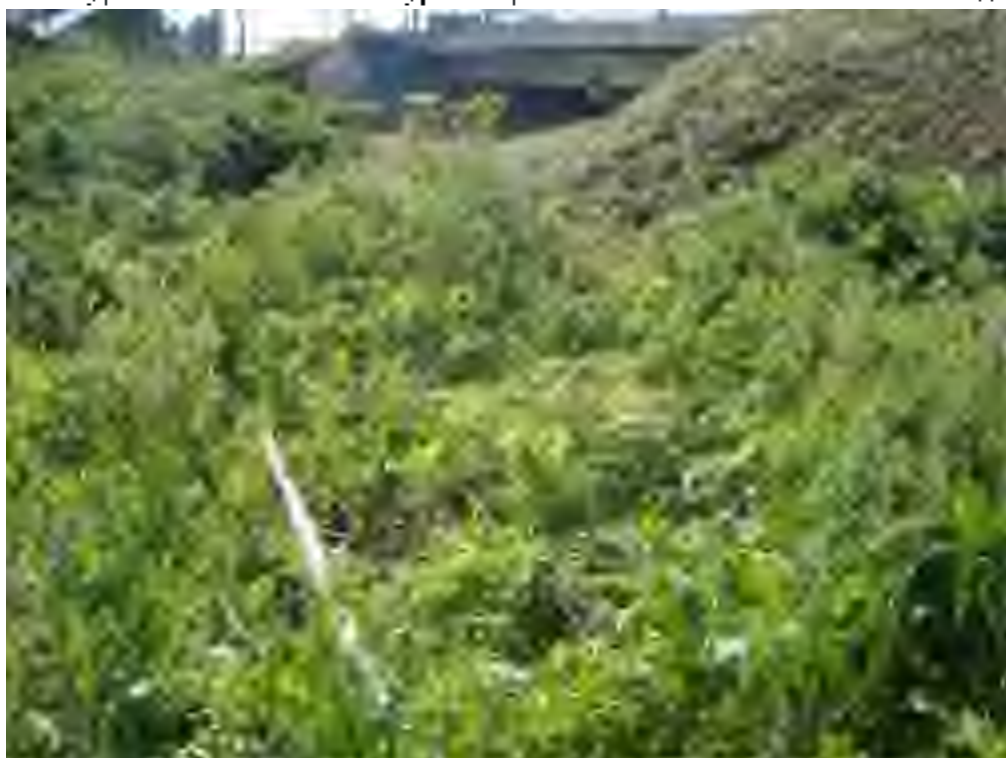
Рис. 9. Объект «Капитальный ремонт моста через реку Крака на км 110+400 автодороги Р-178 Саранск-Сурское-Ульяновск» в Сурском районе Ульяновской области». Место закладки рекогносцировочного шурфа № 1. Вид с З.
