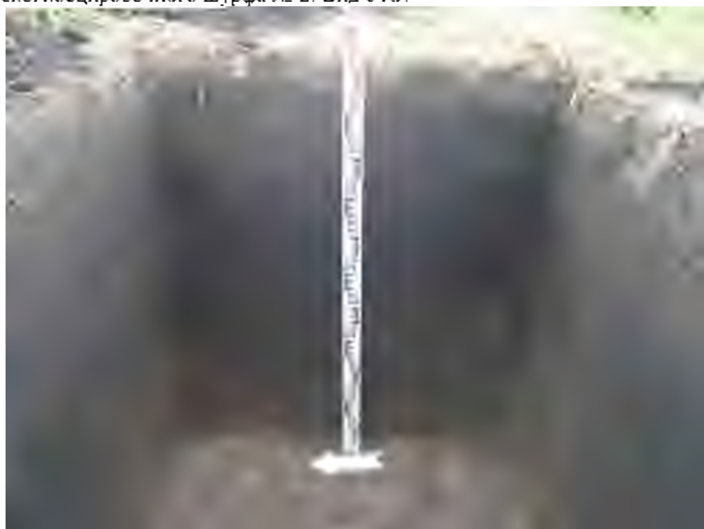
Рис. 17. Объект «Капитальный ремонт моста через реку Крака на км 110–400 автодороги Р-178 Саранск-Сурское-Ульяновск» в Сурском районе Ульяновской области». Восточная стенка рекогносцировочного шурфа № 2. Вид с З.
