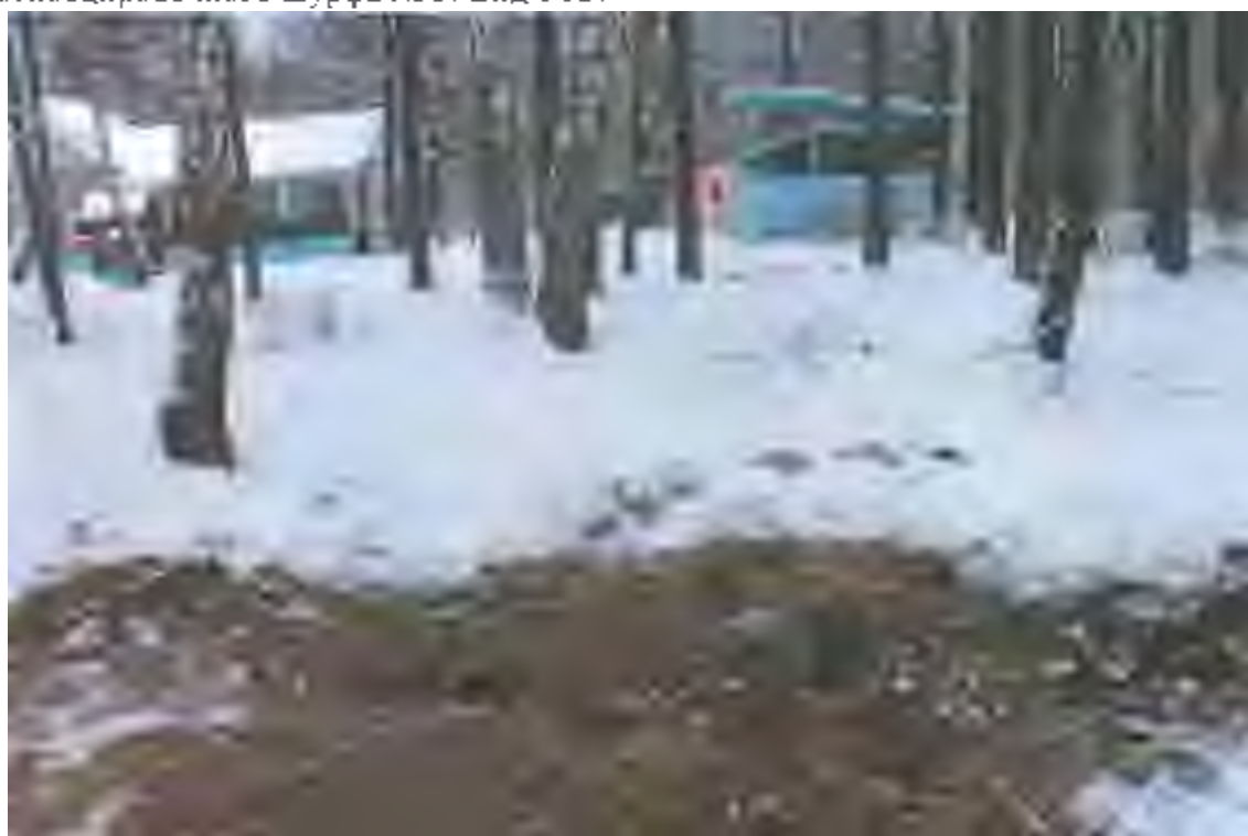
Рис. 18. Объект «Реконструкция детского оздоровительного лагеря «Чайка» по адресу: Ульяновская область, МО «Николаевский район», Николаевское лесничество, Белозерское участковое лесничество, квартал 88, выделы 6, 7, 17». Рекультивация реконструируемого шурфа № 3. Вид с Ю.
