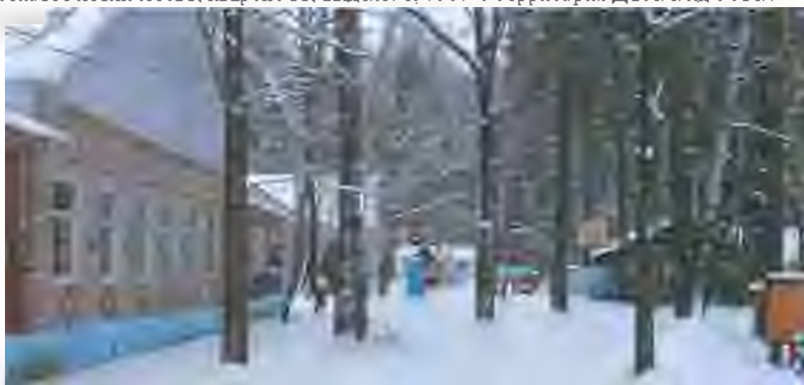
Рис. 3. Объект «Реконструкция детского оздоровительного лагеря «Чайка» по адресу: Ульяновская область, МО «Николаевский район», Николаевское лесничество, Белозерское участковое лесничество, квартал 88, выделы 6, 7, 17». Территория ДОЛ. Вид с ЮВ.
