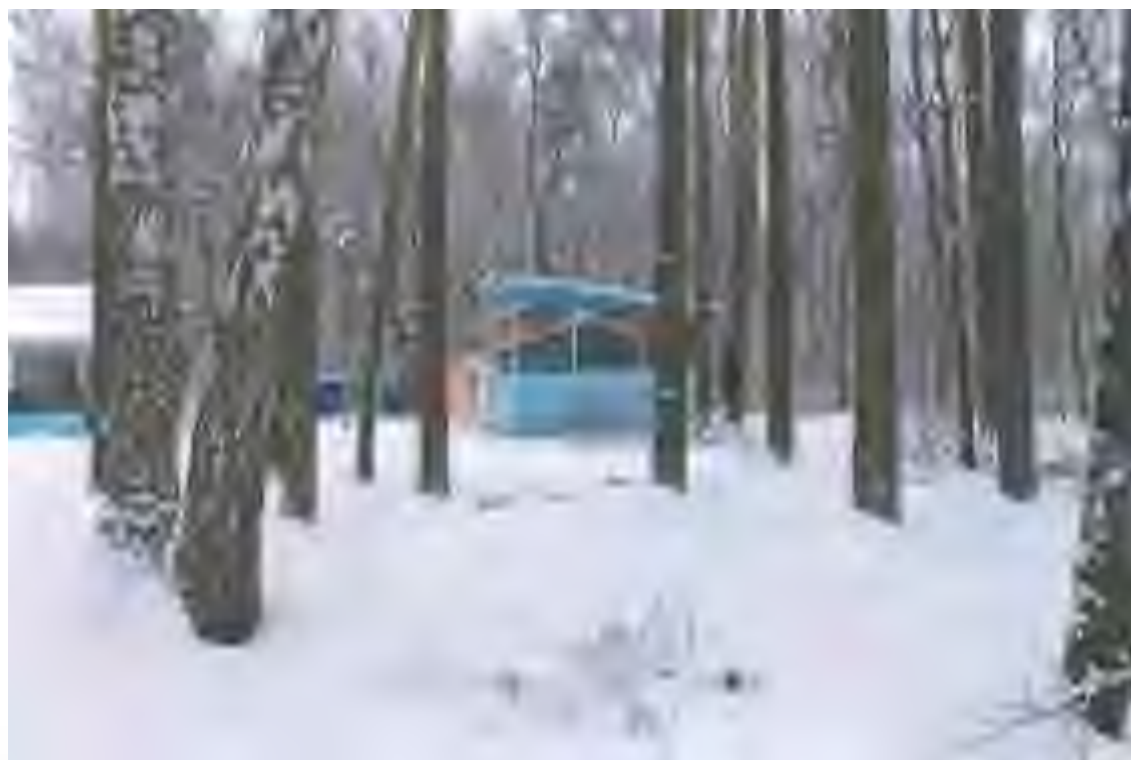
Рис. 5. Объект «Реконструкция детского оздоровительного лагеря «Чайка» по адресу: Ульяновская область, МО «Николаевский район», Николаевское лесничество, Белозерское участковое лесничество, квартал 88, выделы 6, 7, 17». Территория ДОЛ. Вид с ЮЗ.
