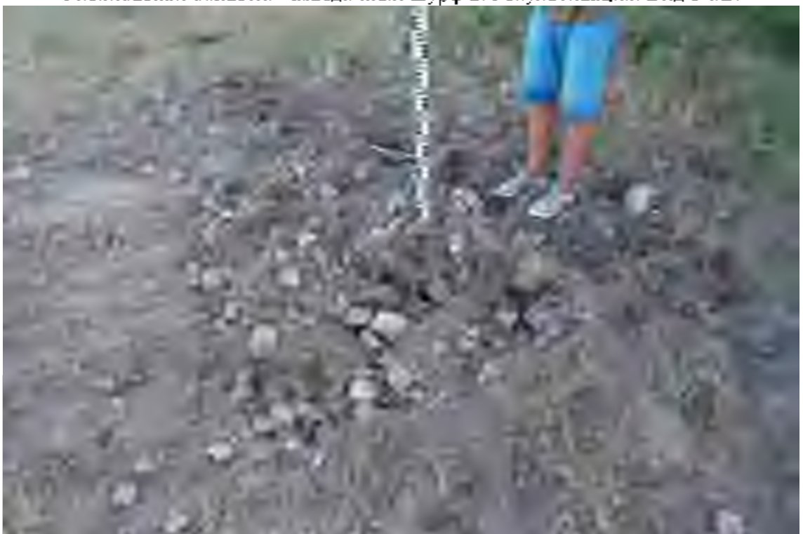
Рис. 30. Объект: «МНПП «Уфа-Западное направление», Dn500 Малый водоток р.Томышовка, 724 км (основная нитка). Реконструкция» в Новоспасском районе Ульяновской области. Разведочный шурф 2. Рекультивация. Вид с СВ.
