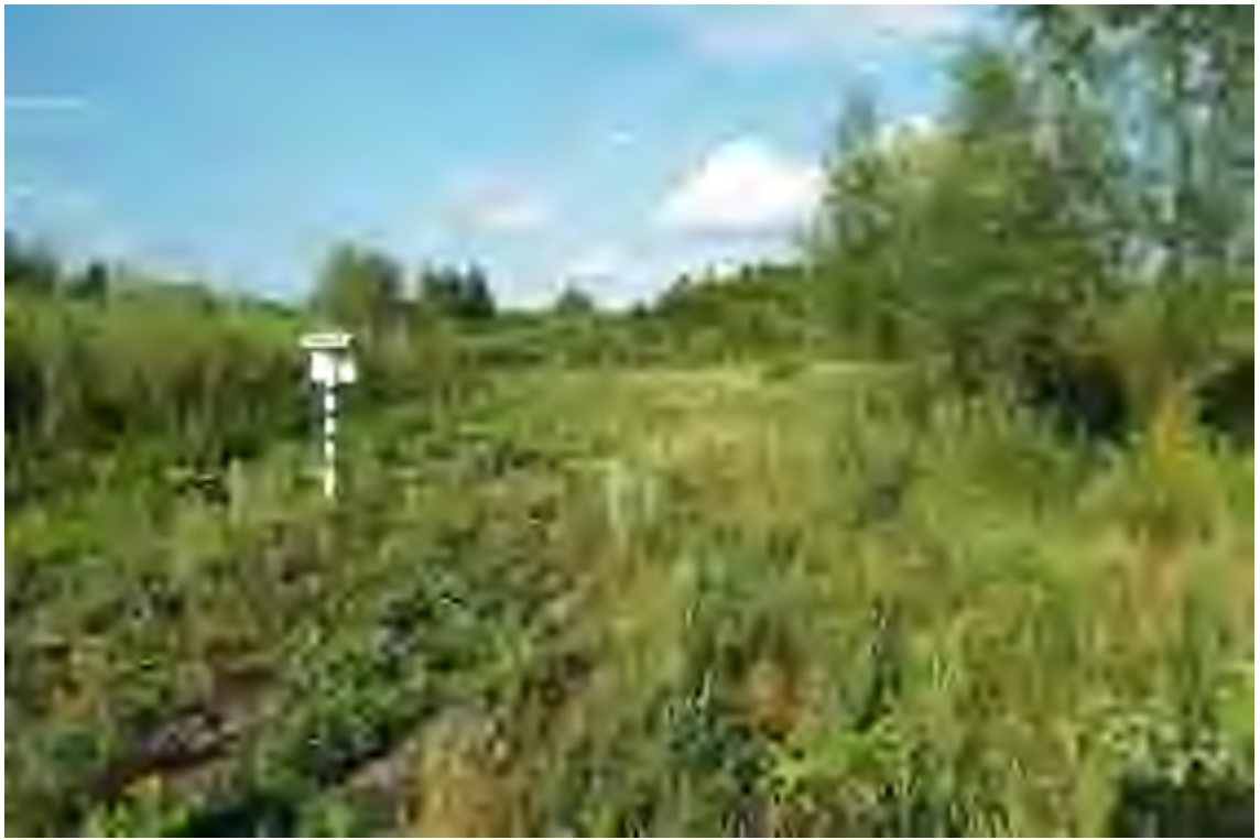
Рис. 9. Объект: «МНПП «Уфа-Западное направление», Дп500. Малый водоток р.Томышовка. 724 км (основная нитка). Реконструкция» в Повоспасском районе Ульяновской области. Вид с СВ.
