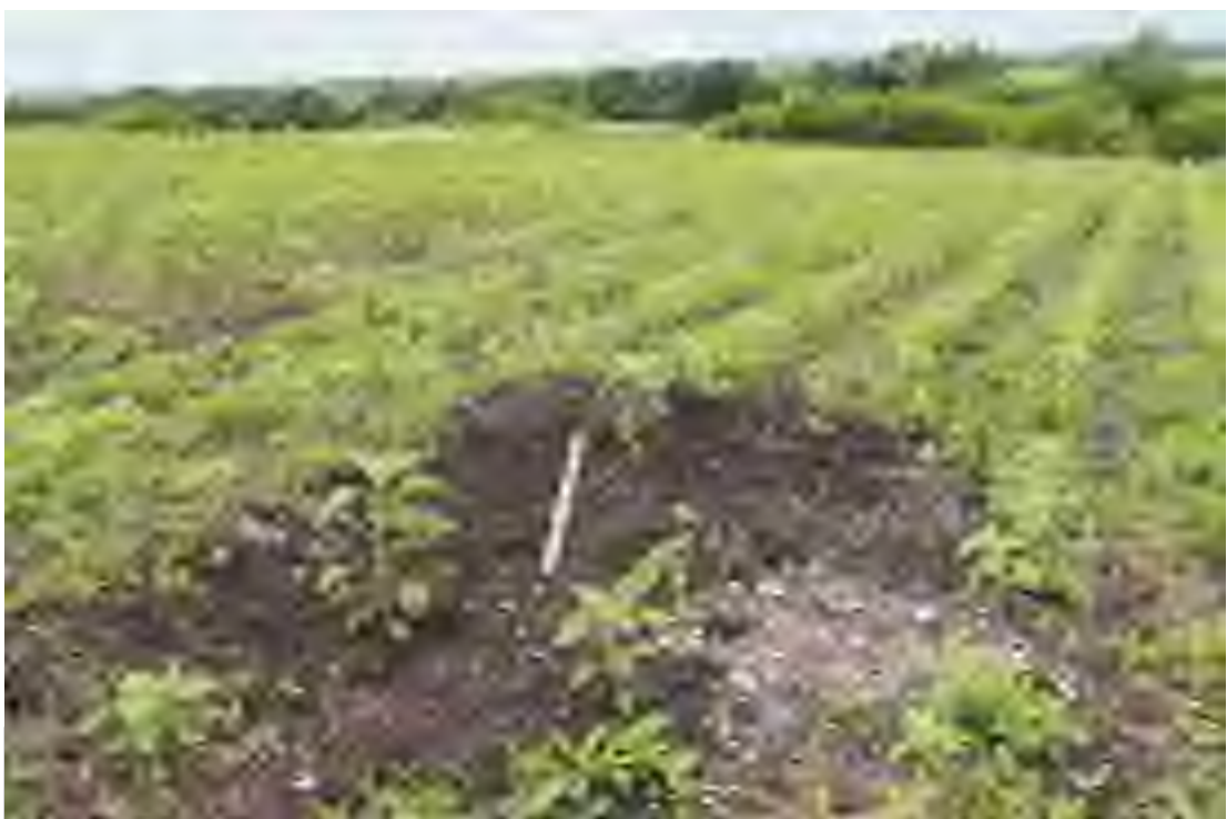
Рис. 40. Объект: «Газопровод межпоселковый от ГРС р.п. Тереньга - с. Тумкино- с. Назайкино- с. Красноборск с ответвлением на -с. Федькино, с. Байдулино» Теренгульского района Ульяновской области. Вид с С на консервацию шурфа 7.
