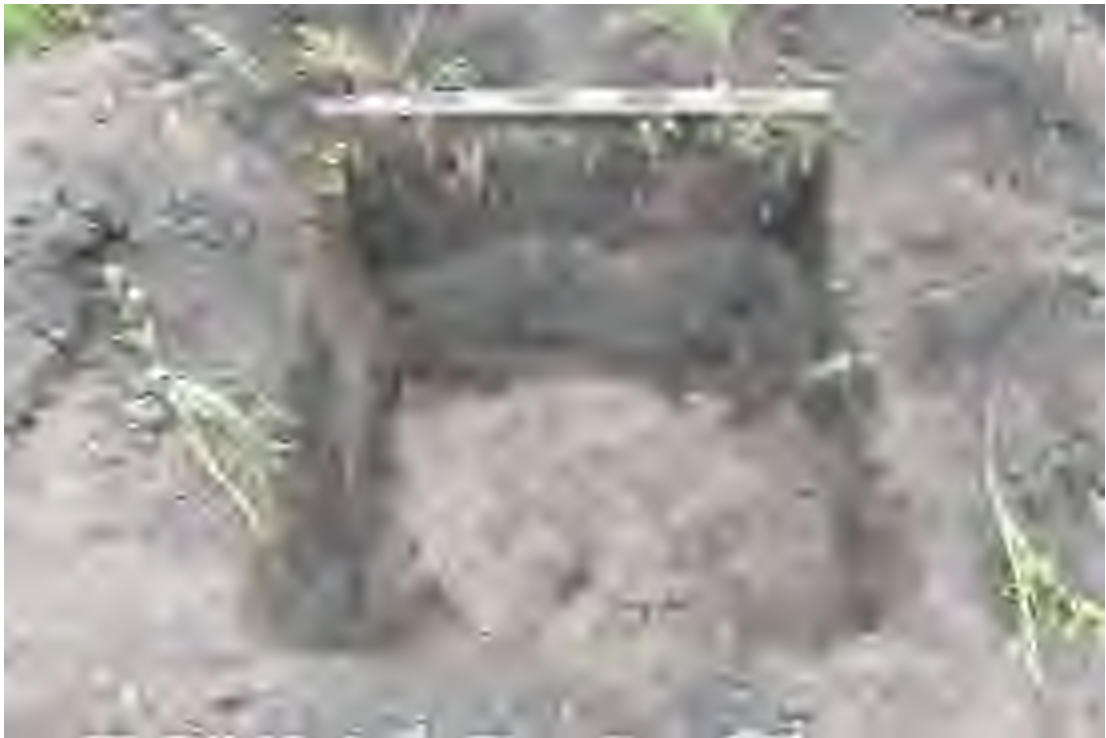
Рис. 35. Объект: «Газопровод межпоселковый от ГРС р.п. Тереньга - с. Тумкино- с. Назайкино- с. Красноборск с ответвлением на -с. Федькино, с. Байдулино» Теренгульского района Ульяновской области. Вид с Ю на контрольную прокопку для шурфа 6.
