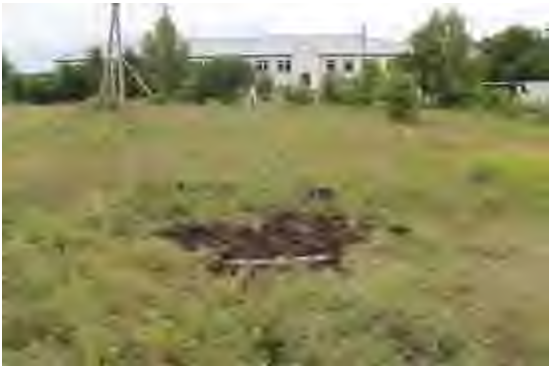
Рис. 16. Объект: «Газопровод межпоселковый от ГРС р.п. Тереньга - с. Тумкино- с. Назайкино- с. Красноборск с ответвлением на -с. Федькино, с. Байдулино» Теренгульского района Ульяновской области. Вид с Ю на консервацию шурфа I.
