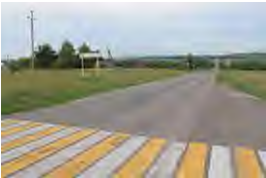
Рис. 12. Объект: «Газопровод межпоселковый от ГРС р.п. Тереньга - с. Тумкино- с. Назайкино- с. Красноборск с ответвлением на -с. Федькино, с. Байдулино» Теренгульского района Ульяновской области. Вид с СВ на конечный участок трассы на северной окраине с. Байдулино.
