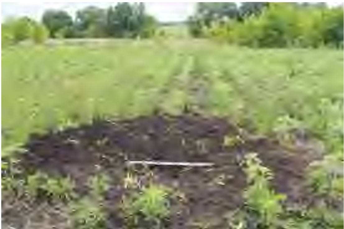
Рис. 44. Объект: «Газопровод межпоселковый от ГРС р.п. Тереньга - с. Тумкино- с. Назайкино- с. Красноборск с ответвлением на -с. Федькино, с. Байдулино» Теренгульского района Ульяновской области. Вид с С на консервацию шурфа 8.
