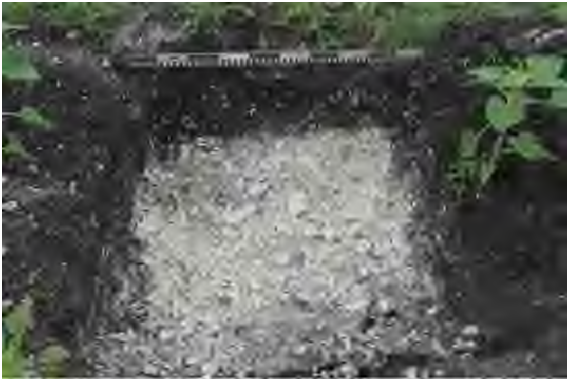
Рис. 39. Объект: «Газопровод межпоселковый от ГРС р.п. Тереньга - с. Тумкино- с. Назайкино- с. Красноборск с ответвлением на -с. Федькино, с. Байдулино» Теренгульского района Ульяновской области. Вид с Ю на контрольную прокопку для шурфа 7.
