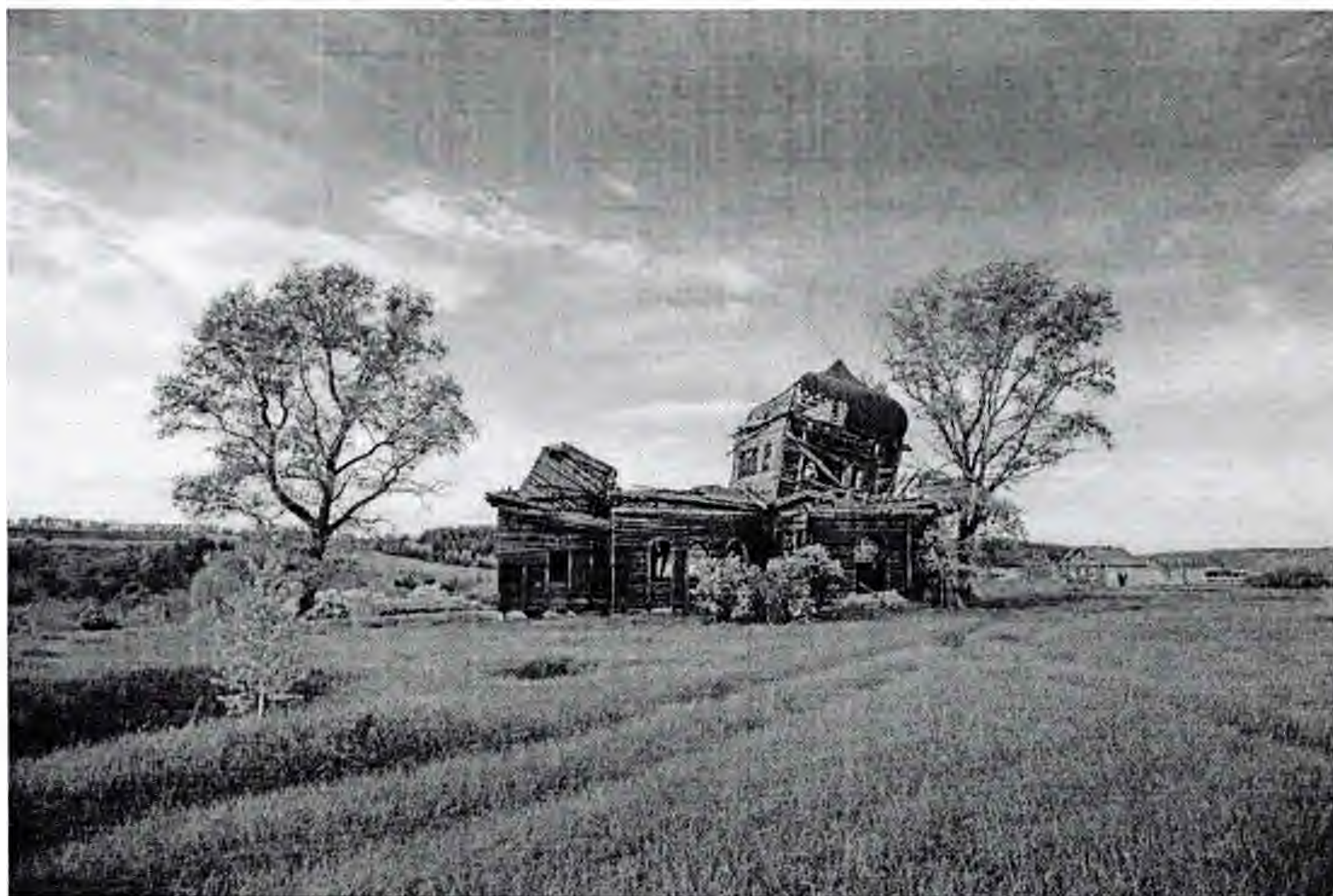
Общий вид объект
