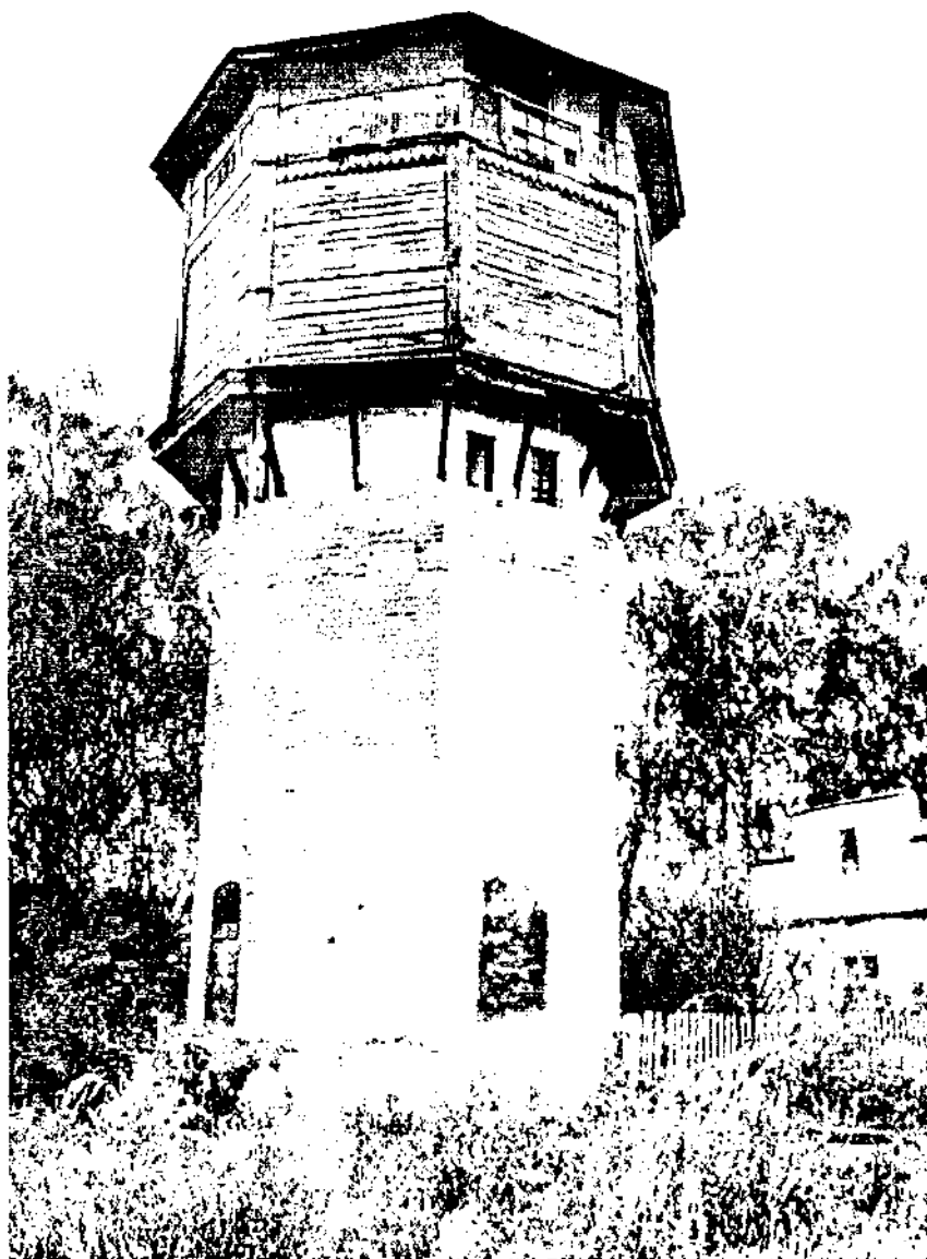
Общий вид на объект с улицы Станционная
