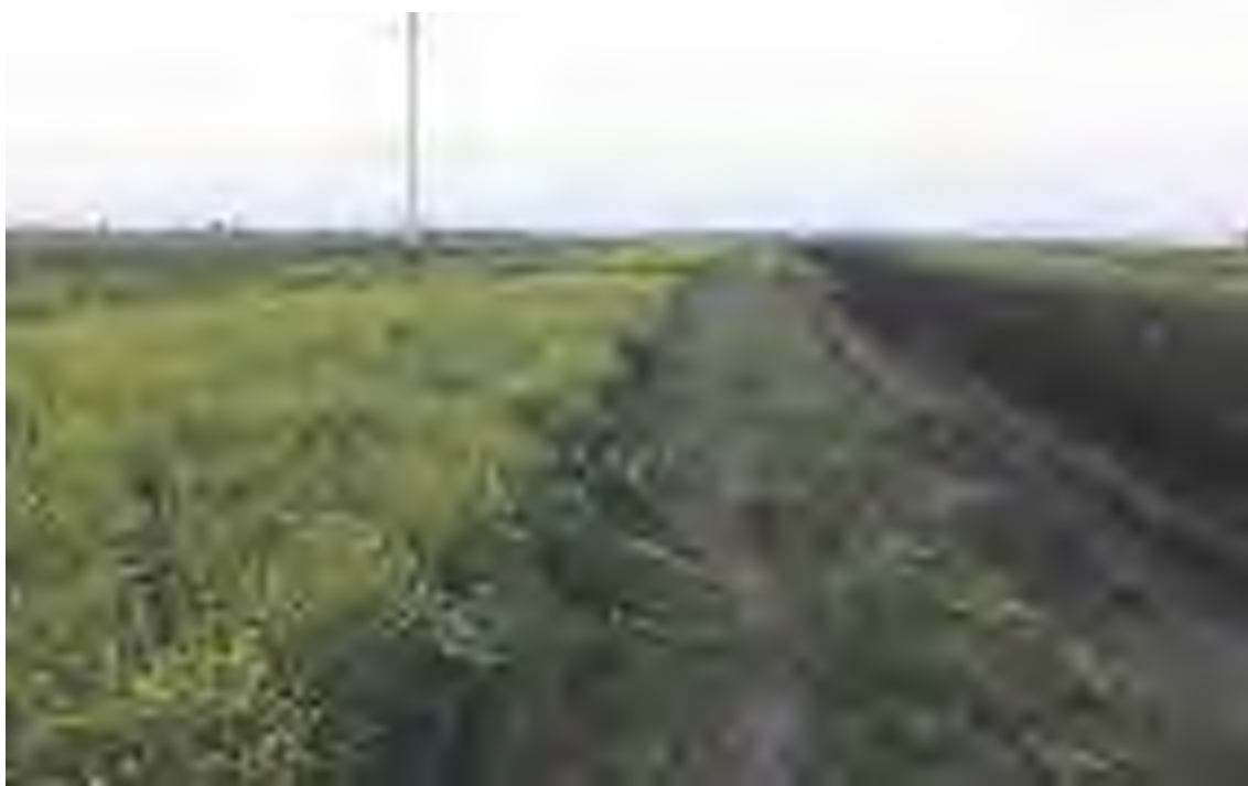
Рис. 14. Объект «Обустройство скважины № 32 Куликовского месторождения». Проектируемый трубопровод. Вид с ССВ.
