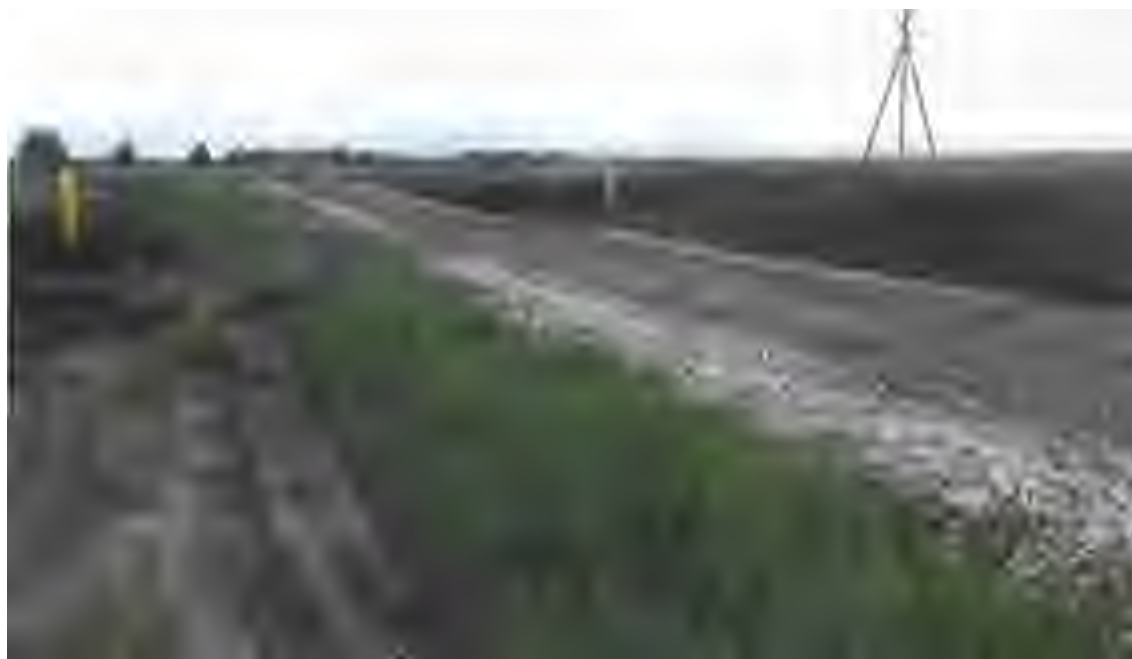
Рис. 11. Объект «Обустройство скважины № 32 Куликовского месторождения». Проектируемый трубопровод. Вид с ЮЗ.
