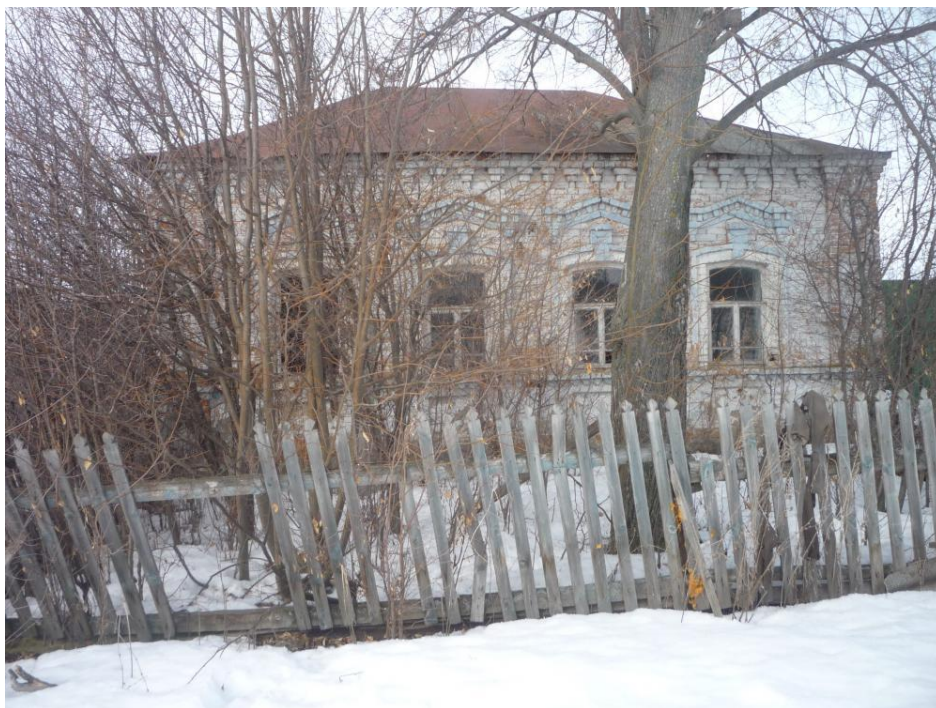
Общий вид на объект.
