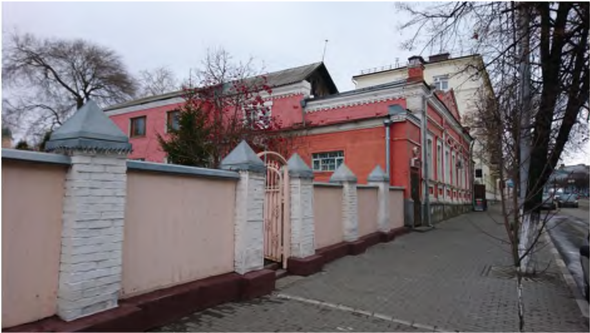
Вид с юго-запада
