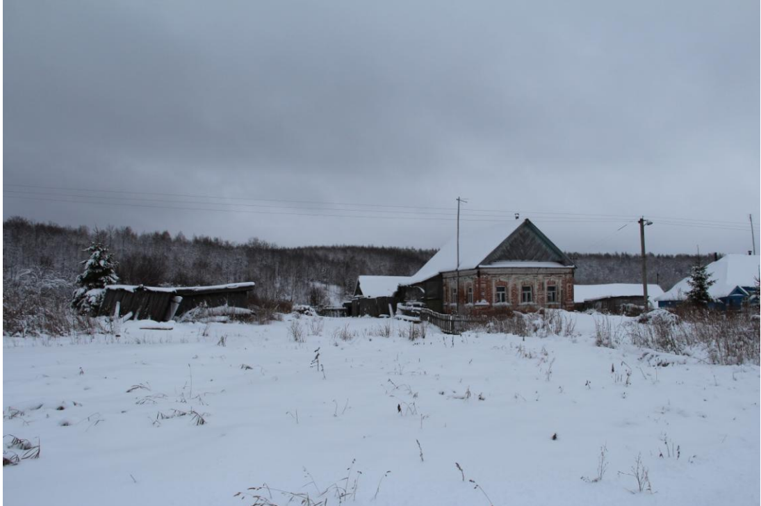
Общий вид на объект по ул. Аксакова
