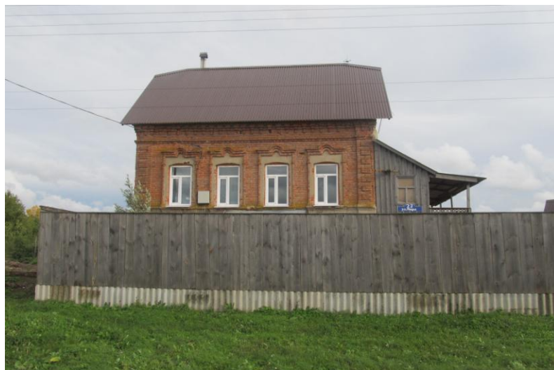
Общий вид на объект
