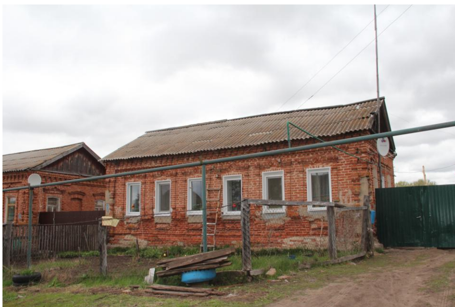
Общий вид на объект
