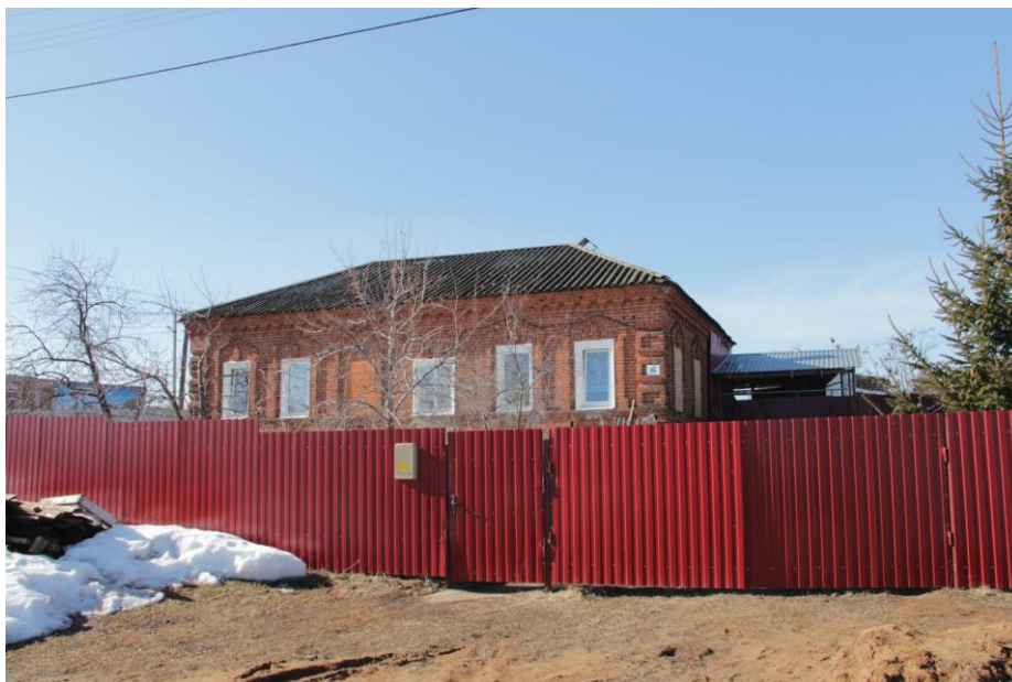
Общий вид на объекта
