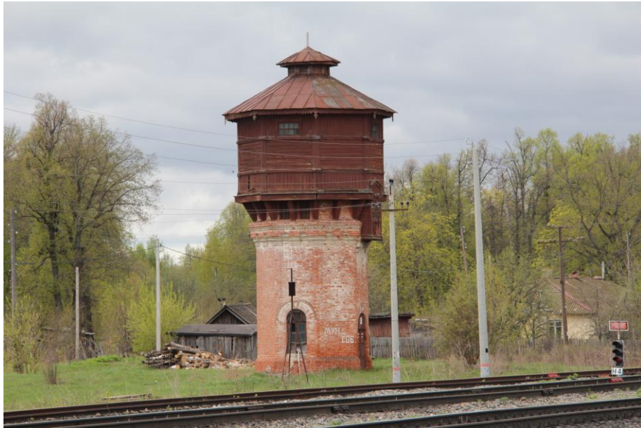
Общий вид на объект
