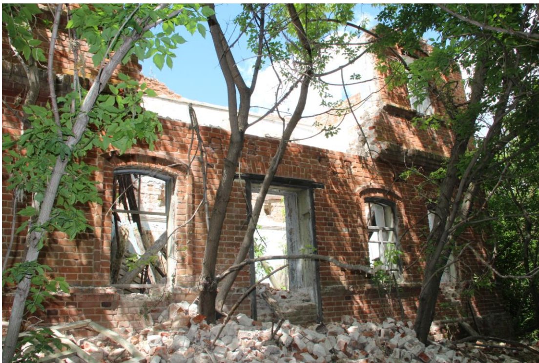
Общий вид объект
