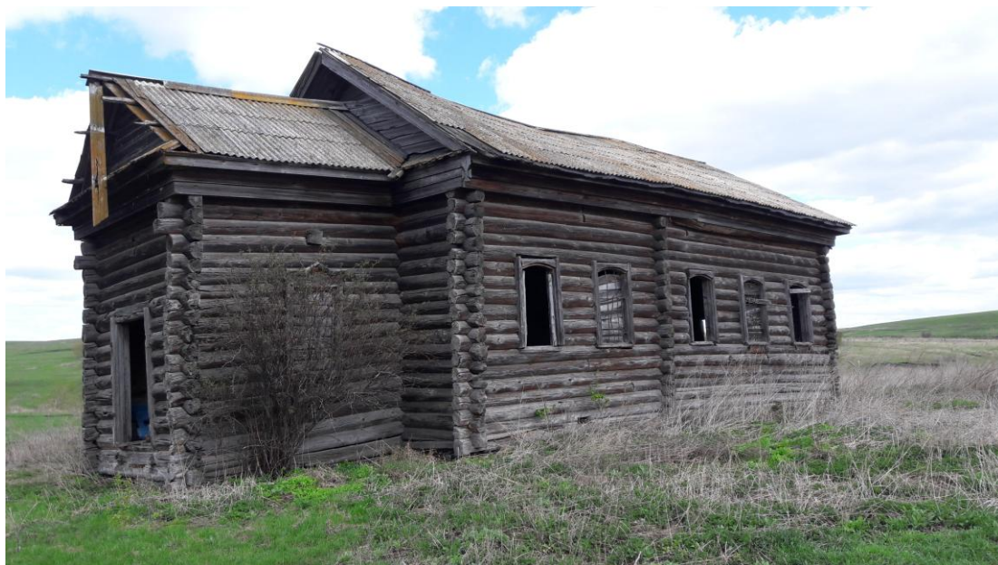
Общий вид объект
